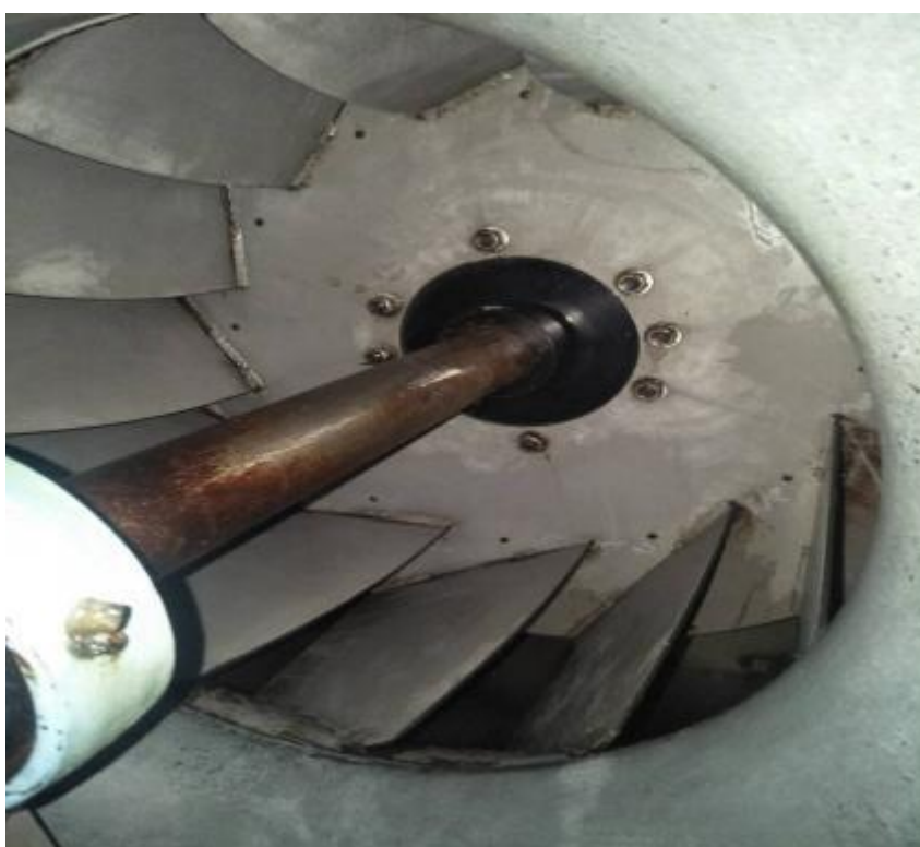
垂直管道清洗后
