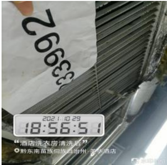
洗衣房管道口清洗前
