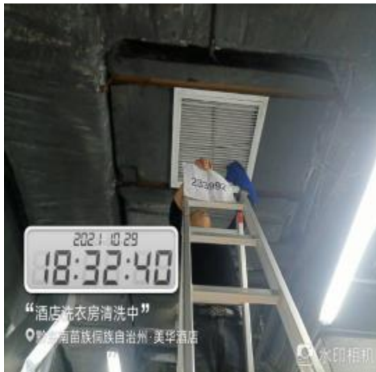
洗衣房管道施工中
