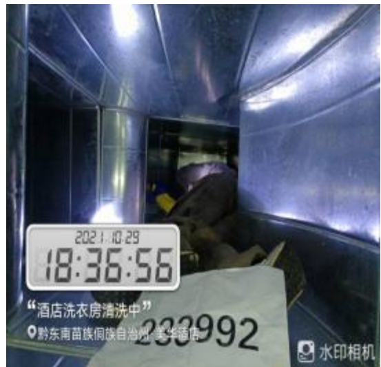
洗衣房管道施工中
