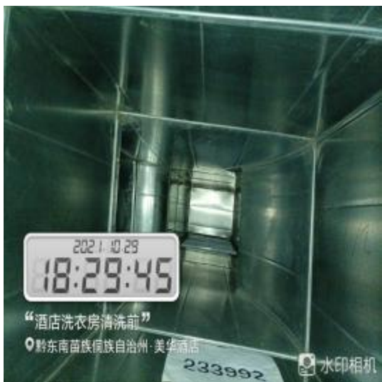
洗衣房管道清洗前
