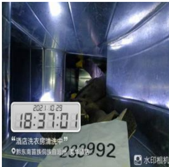
洗衣房管道施工中
