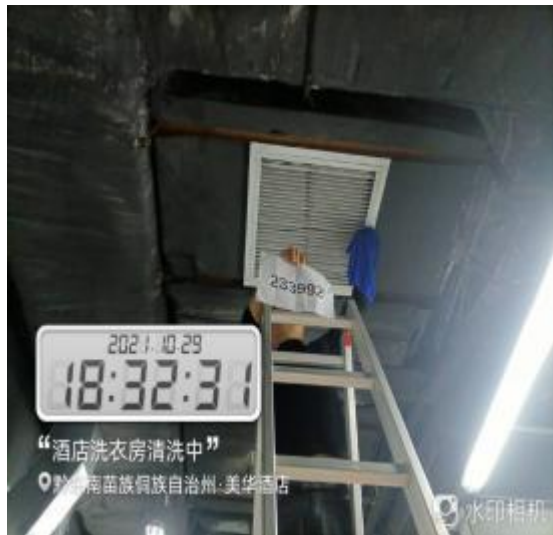
洗衣房管道施工中
