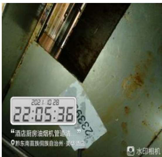
云府餐厅厨房管道清洗中
