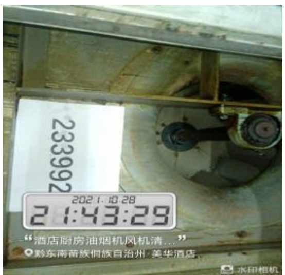
云府餐厅风机清洗前
