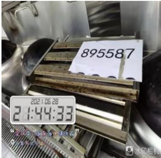
会议防火板清洗前
