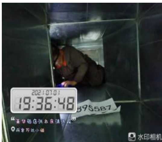
洗衣房管道清洗中
