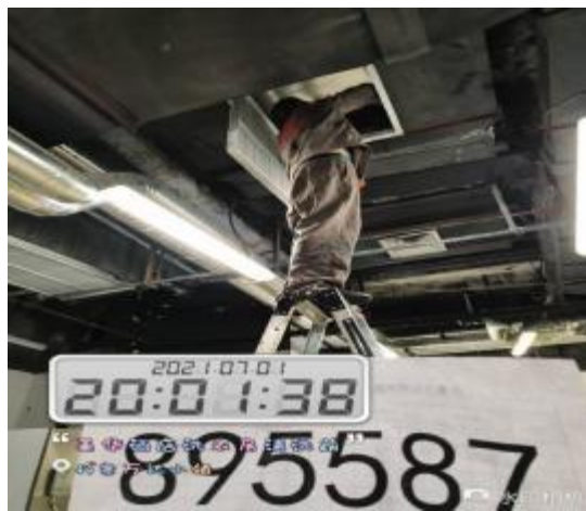
洗衣房管道清洗中
