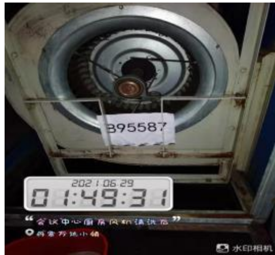
会议厨房风机清洗后
