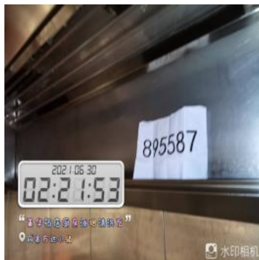
烟罩管道清洗后
