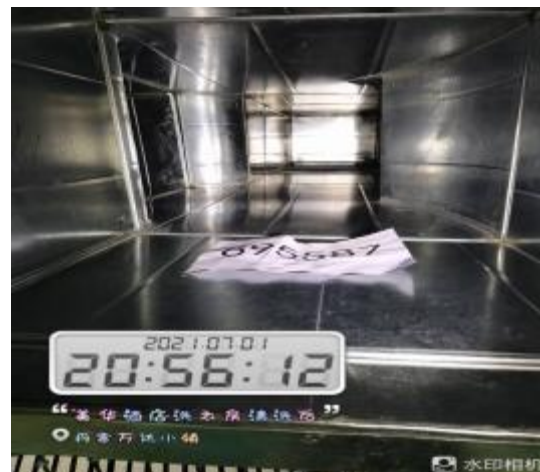
洗衣房管道清洗后
