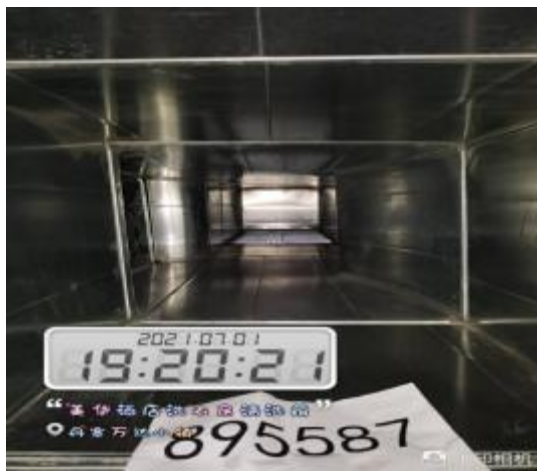
洗衣房清管道洗前
