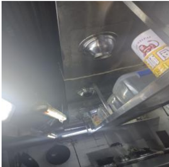
新风管外观清洗前
