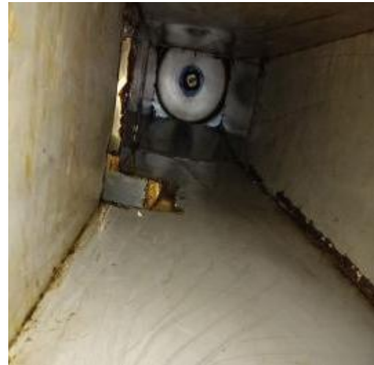
管道风机清洗后
