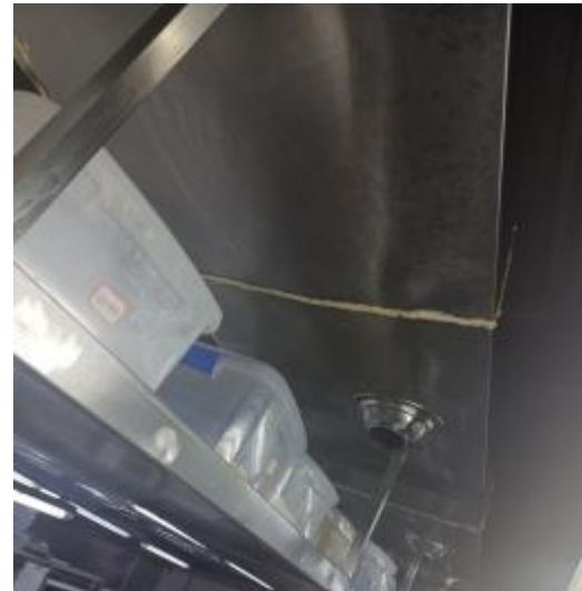
新风管外观清洗后
