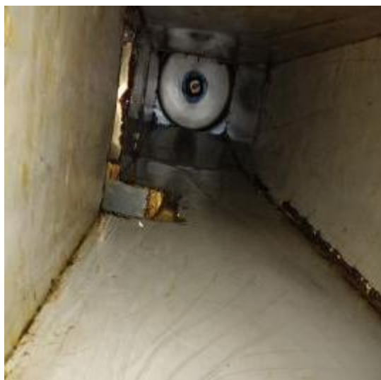
管道风机清洗后
