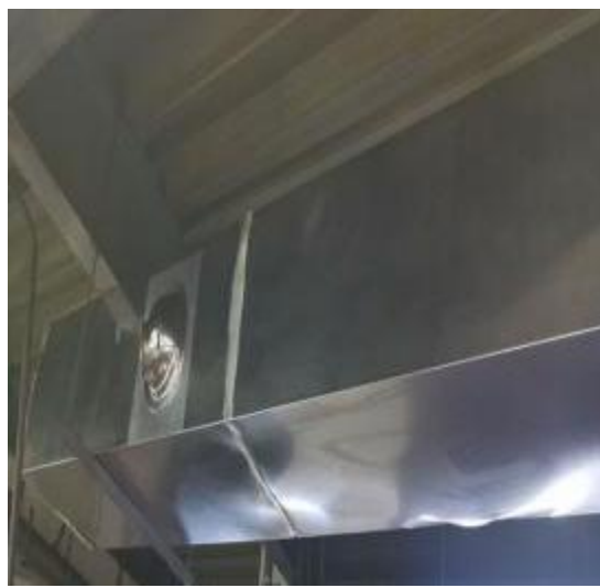
新风管外观清洗后 1
