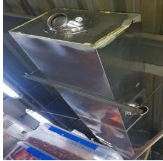
新风管外观清洗后 2
