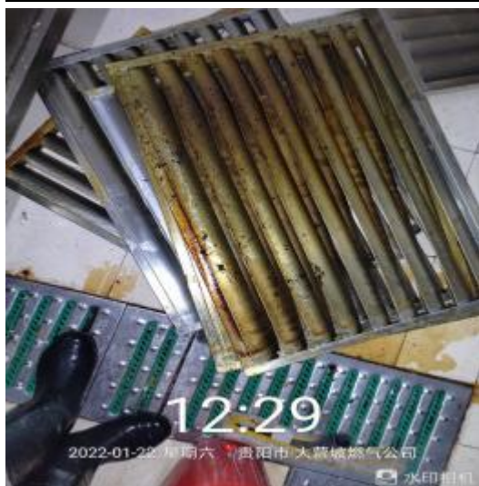
防火板清洗前
