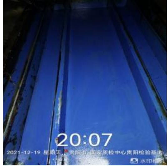
净化器机箱清洗后
