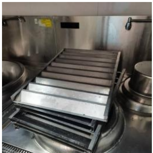
防火板清洗后
