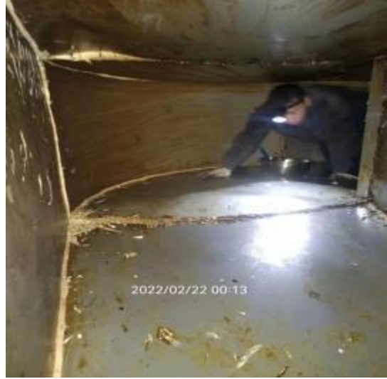
横向管道施工中
