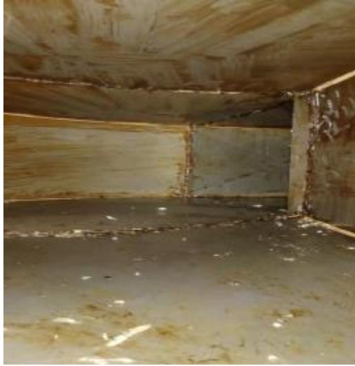
横向管道施工中
