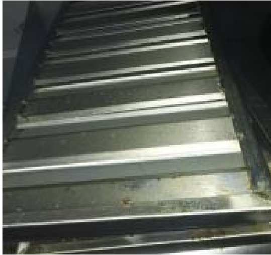
防火板清洗前
