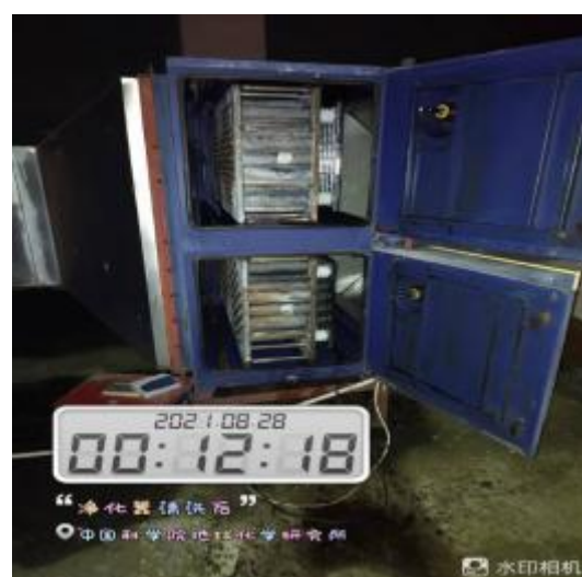
净化器施工中
