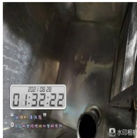
运水控制箱清洗后
