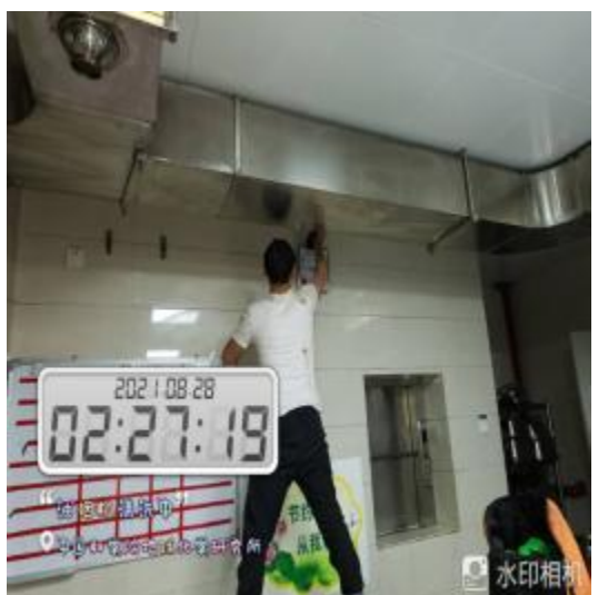
厨房墙面清洁中
