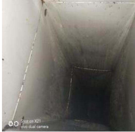
垂直管道清洗后
