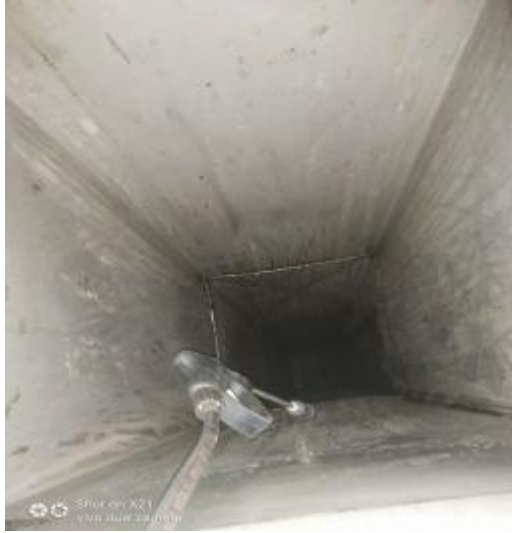
垂直管道清洗前
