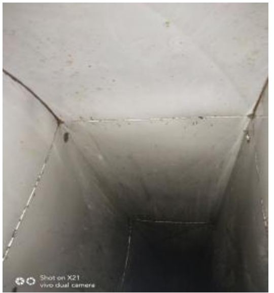
垂直管道清洗前
