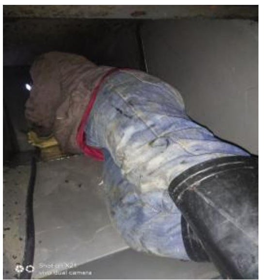
垂直管道清洗中
