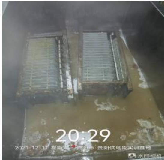
净化器施工中
