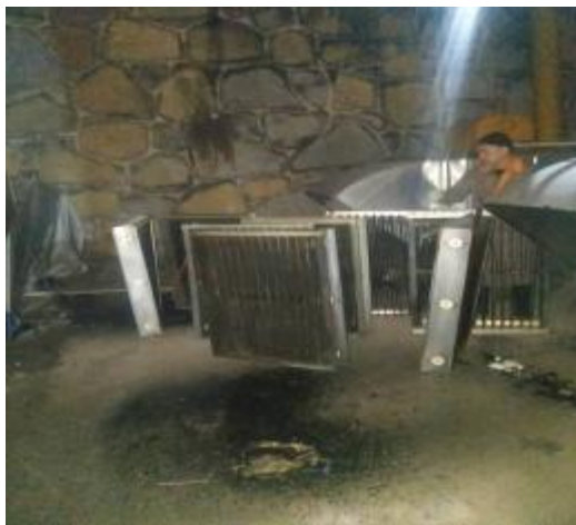
净化器道施工中
