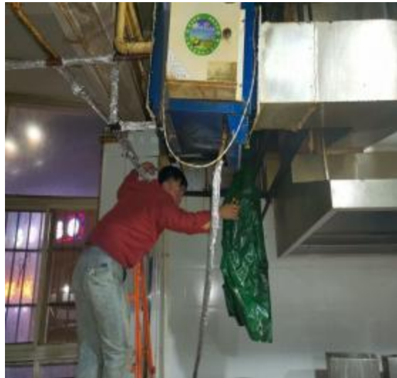
净化器施工中
