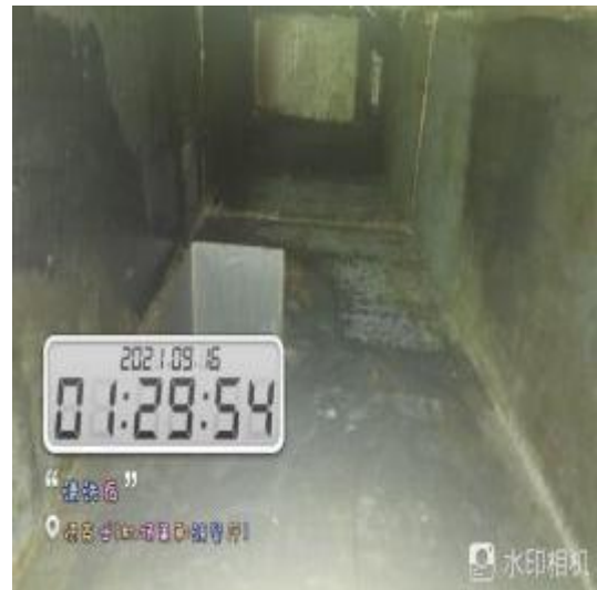
烟罩管道管道清洗后
