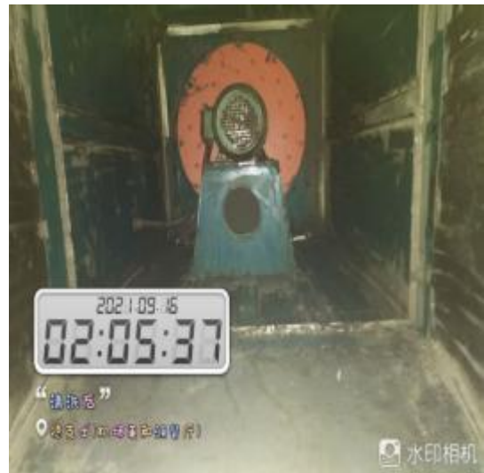
管道风机清洗后
