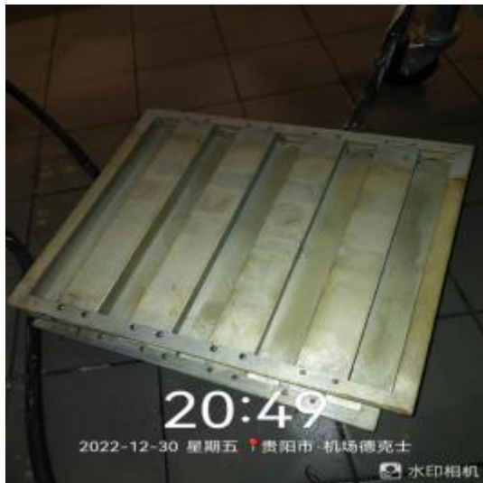
防火板清洗前
