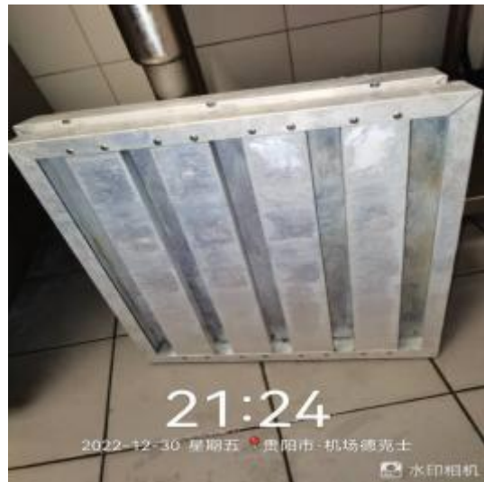
防火板清洗后
