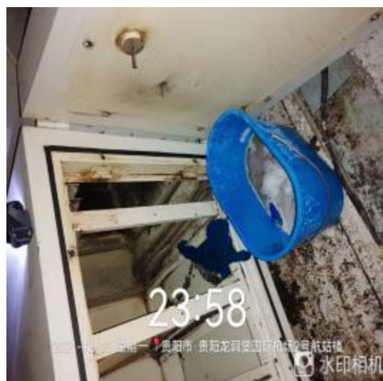
净化器机箱清洗中
