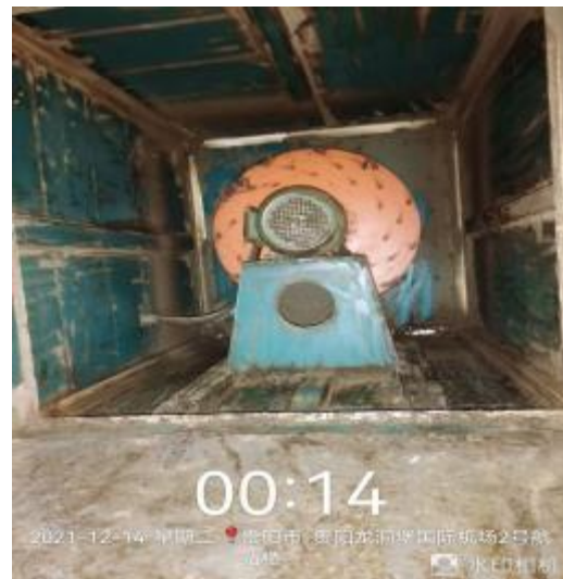
管道风机清洗后
