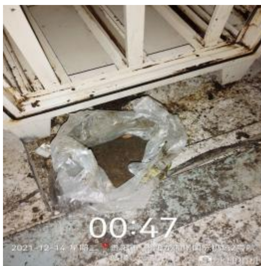
净化器机箱清洗中
