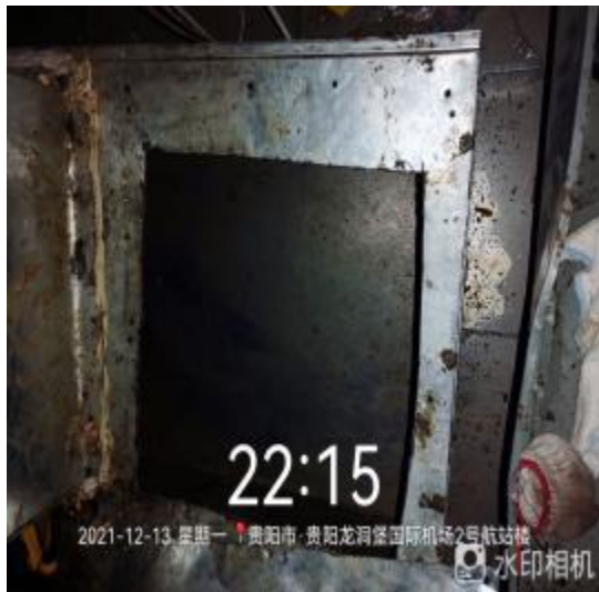
管道口清洗前
