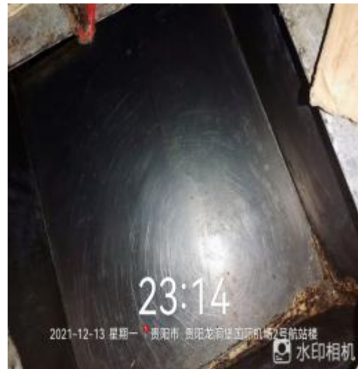
管道口清洗后
