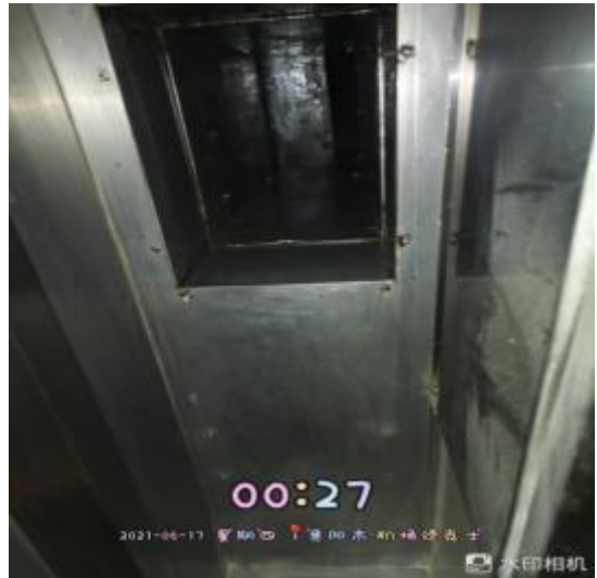
烟罩管道清洗后
