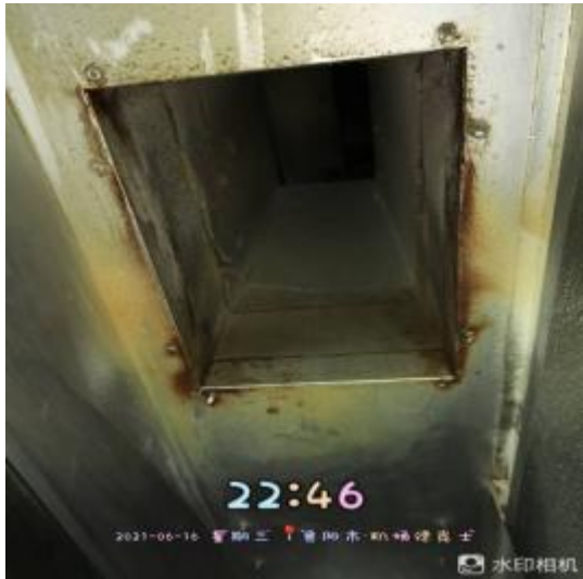
烟罩管道清洗前
