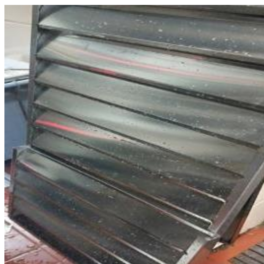
防火板清洗后
