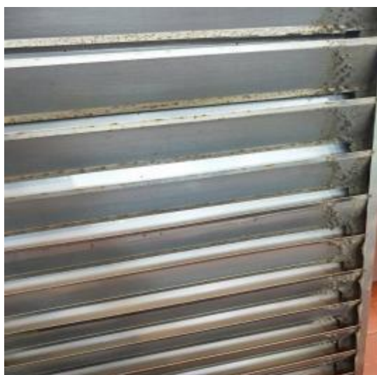
防火板清洗前
