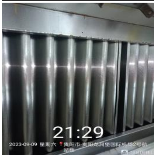
防火板清洗前
