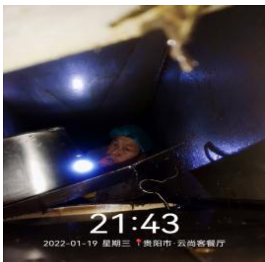
大厨房管道清洗中
