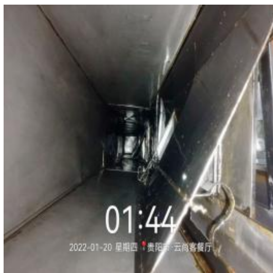
大厨房管道清洗后
