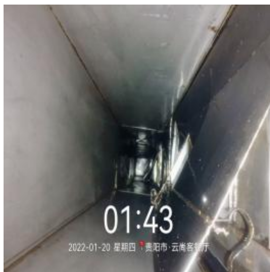
大厨房管道清洗中
