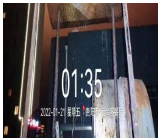
风出风口施工中
