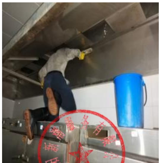
蒸饭柜烟罩清洗中
