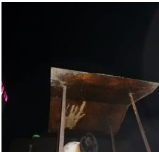
楼顶出风口施工中
