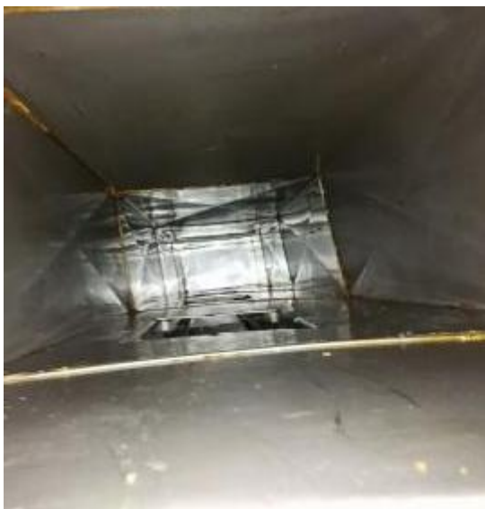
大厨房管道清洗后
