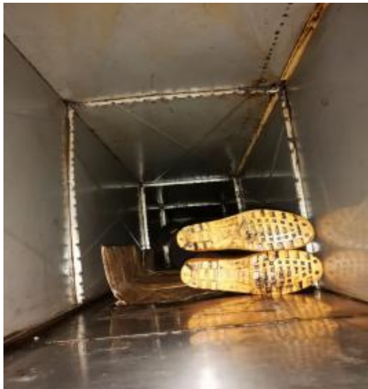
大厨房管道清洗中
