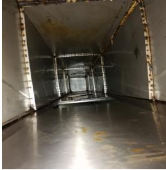
大厨房管道清洗中
