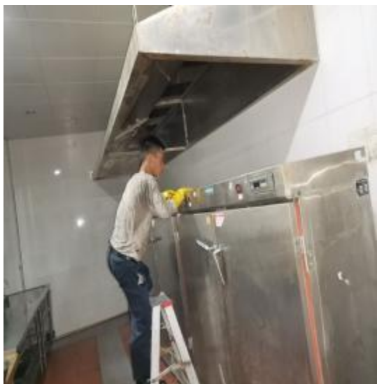
蒸饭柜烟罩施工中
