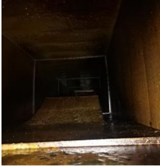
大厨房管道清洗前
