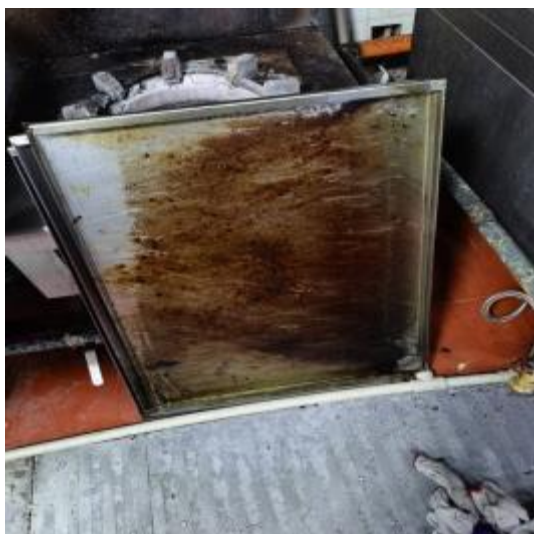
大厨房防火板清洗前
