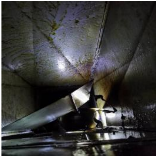
大厨房管道清洗前
