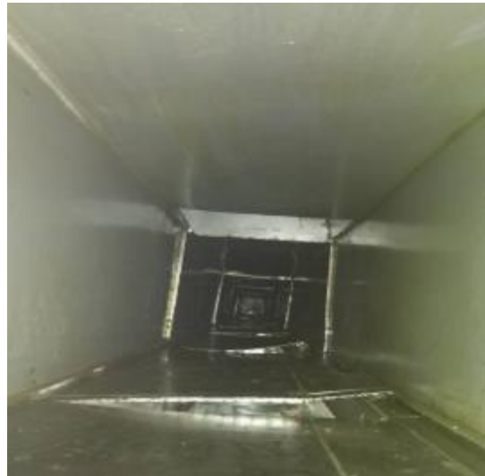
大厨房管道清洗中
