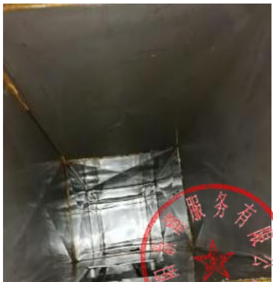
大厨房管道清洗后
