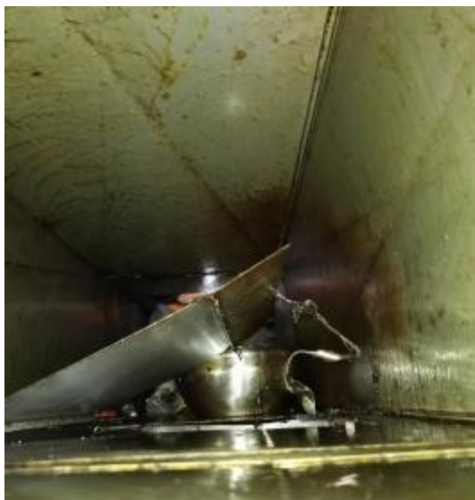
大厨房管道清洗中
