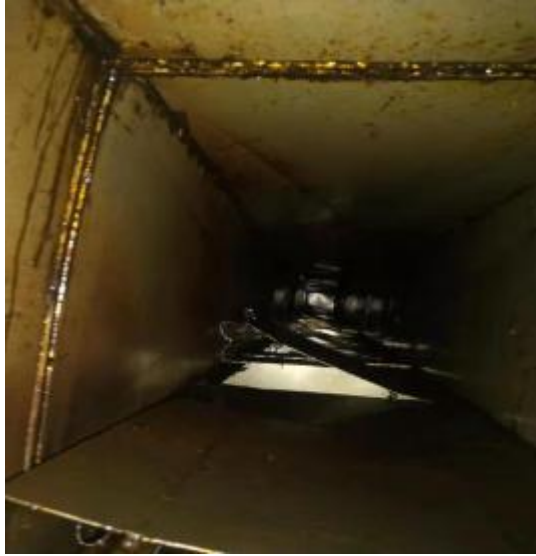
大厨房管道清洗前
