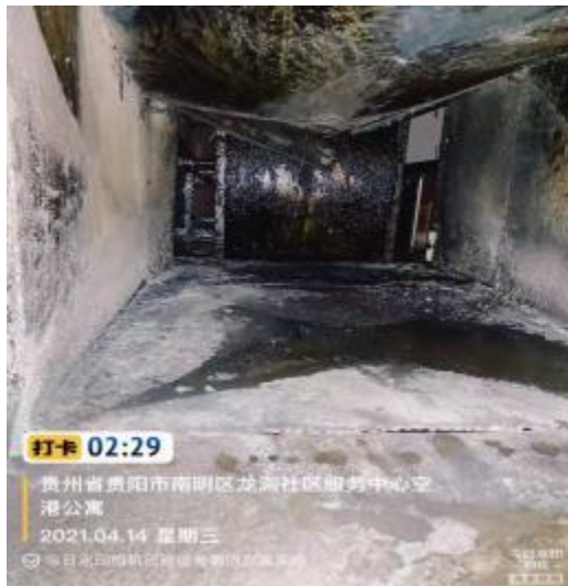
楼顶管道清洗前
