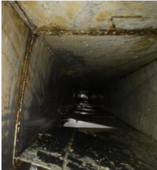
大厨房管道清洗中
