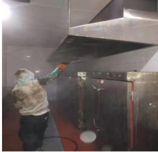
蒸饭柜烟罩清洗中
