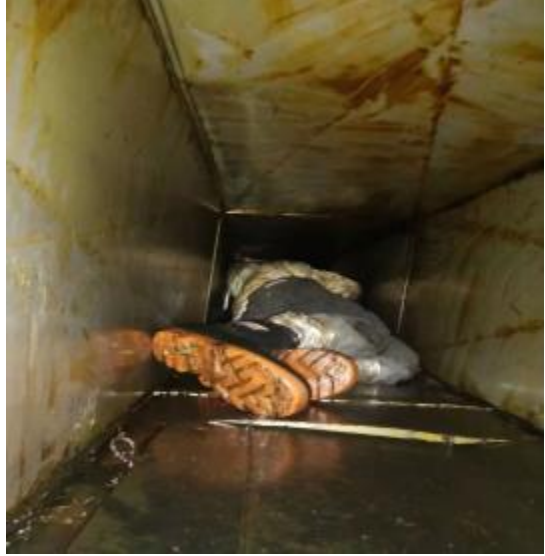
大厨房管道清洗中
