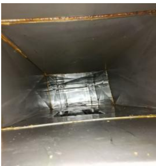
大厨房管道清洗后
