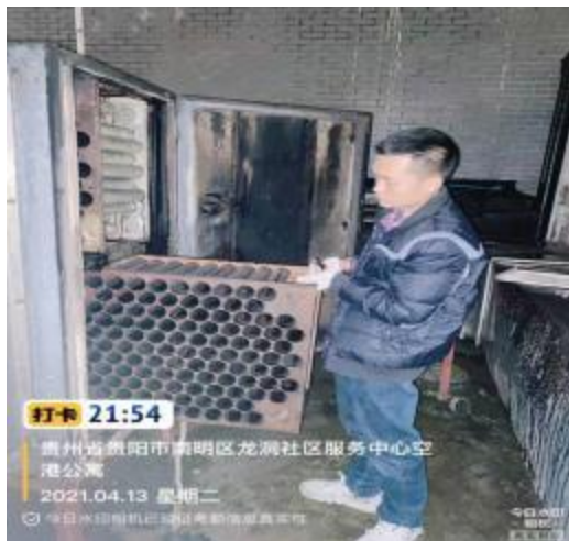
净化器施工中
