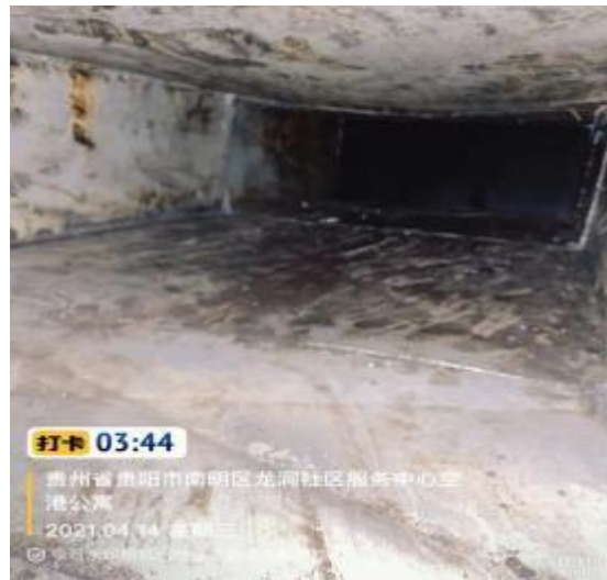
楼顶管道清洗后
