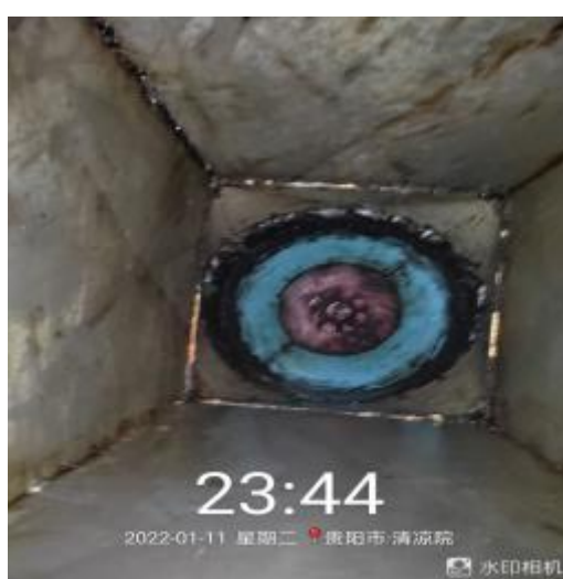
5号楼风机管道清洗后
