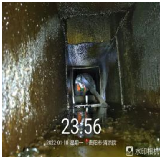
7号楼厨房管道清洗中
