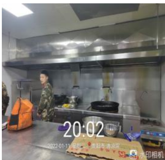
5号楼烟罩施工中
