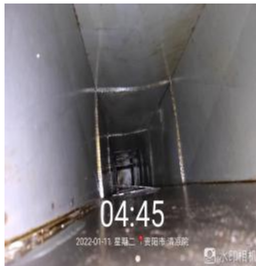
7号楼厨房管道施工中
