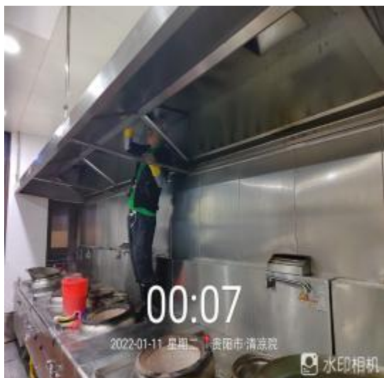
7号楼烟罩施工中
