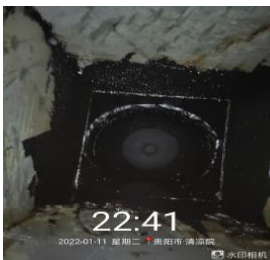
5号楼风机管道清洗后
