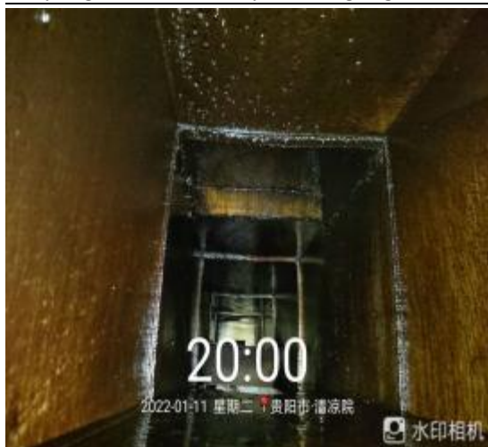
5号楼管道清洗前
