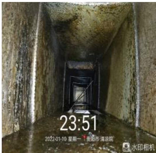
7号楼厨房管道清洗前
