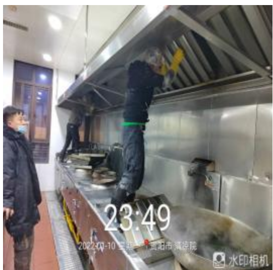
7号楼烟罩施工中
