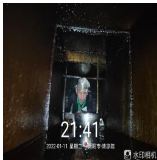
5号楼管道施工中
