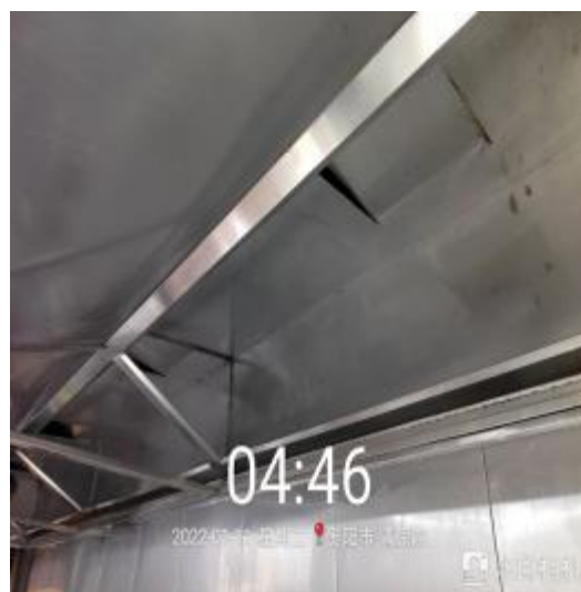
7号楼烟罩施工后
