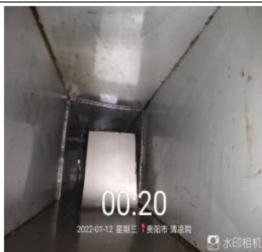
5号楼管道清洗后
