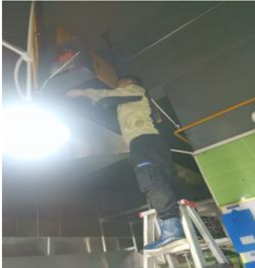
净化器机箱施工中
