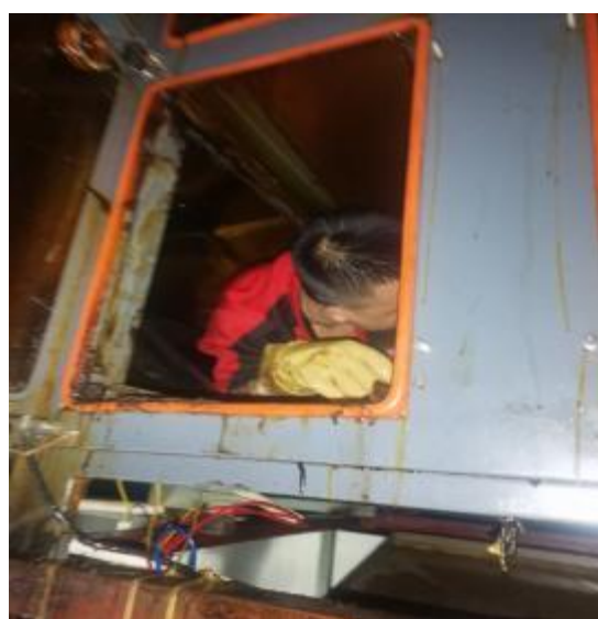
净化器机箱清洗中
