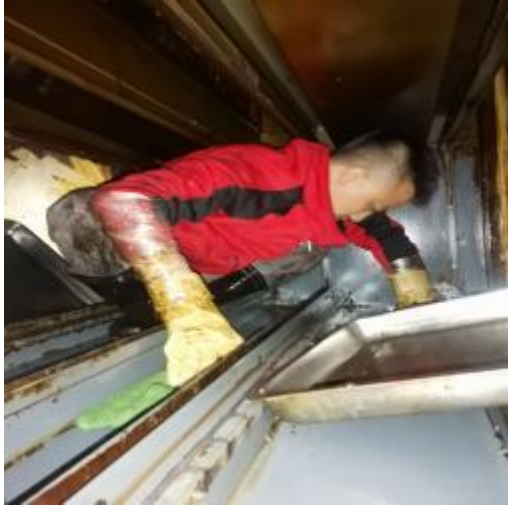
净化器机箱施工中
