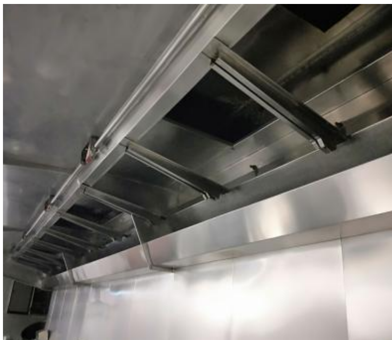
宴会厨房烟罩清洗后
