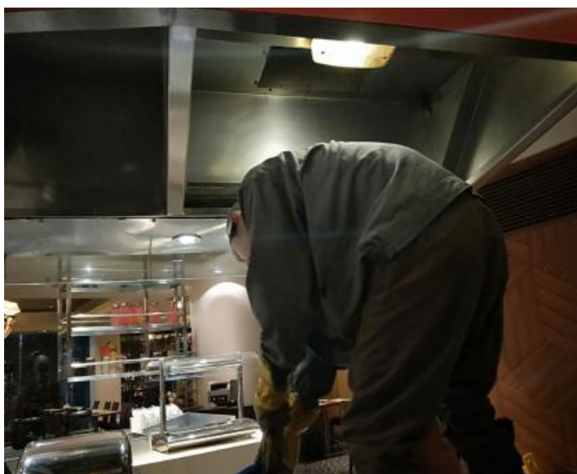
西厨房烟罩施工中
