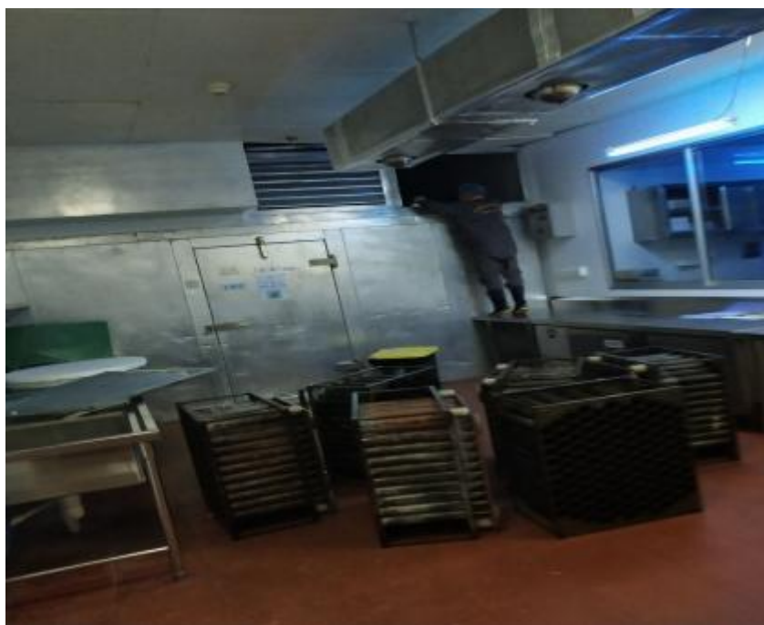
净化器施工中
