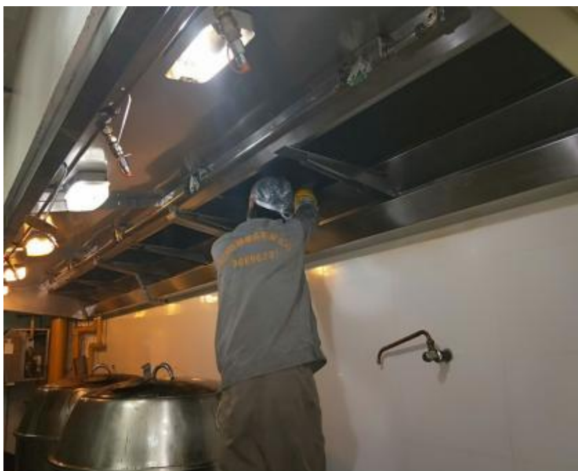
烧腊间烟罩施工中
