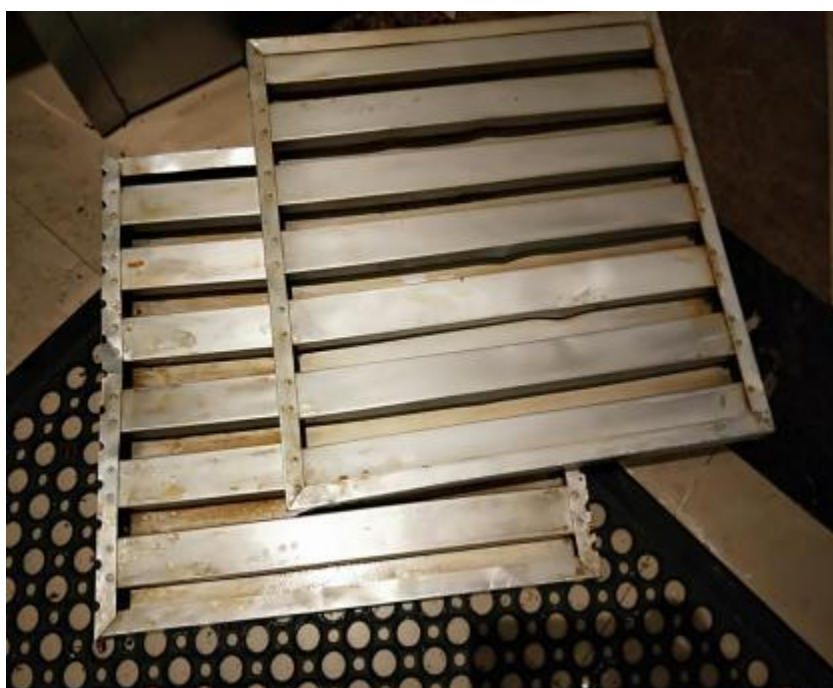
西厨房挡板清洗前
