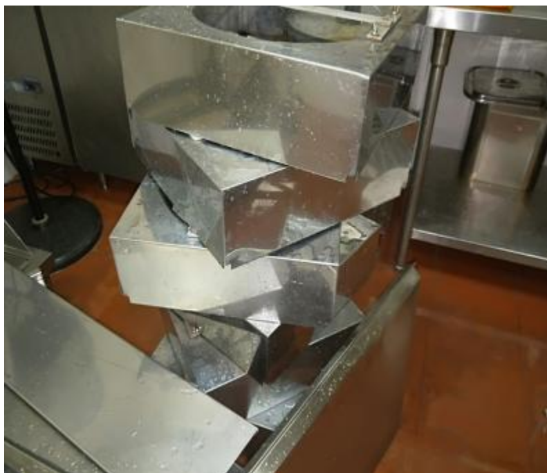
烧腊间风扇清洗后
