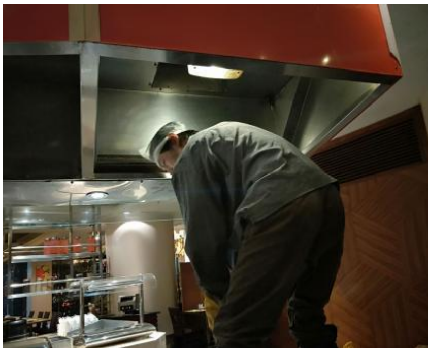
明档烟罩施工中
