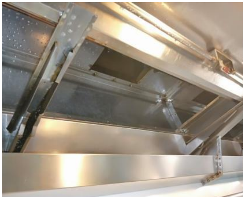
西厨房烟罩清洗后
