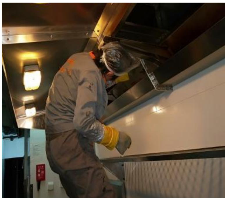
38 楼烟罩施工中
