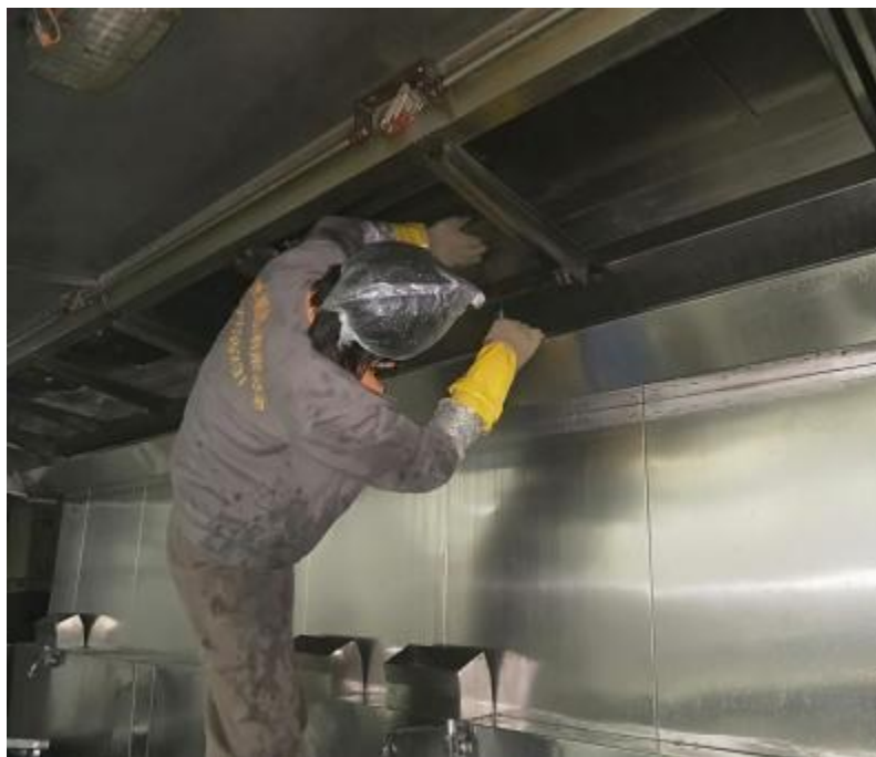
宴会厨房烟罩施工中
