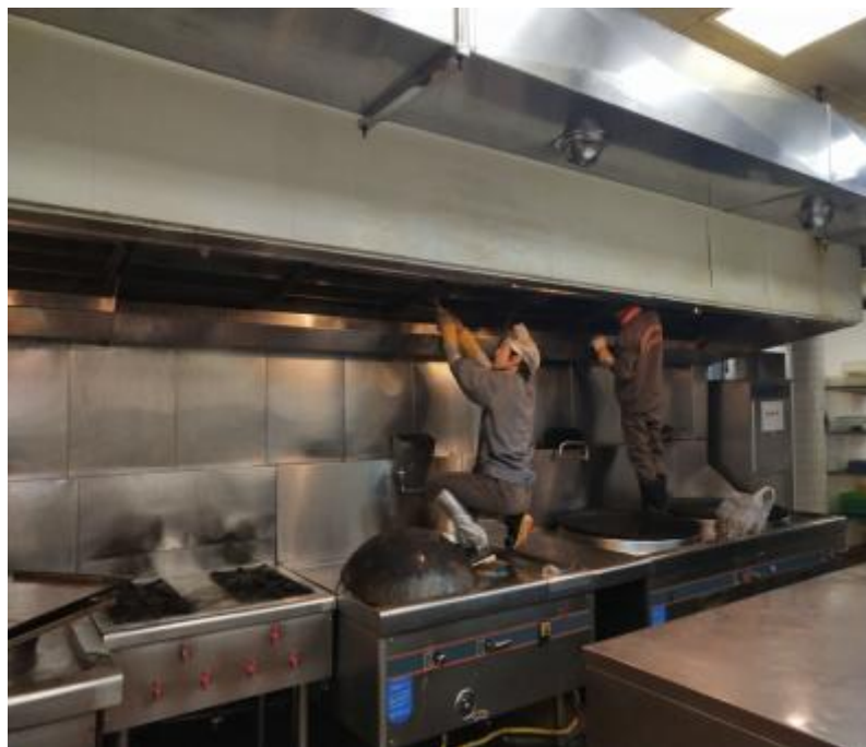
员工厨房烟罩施工中
