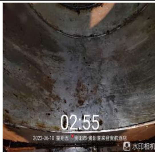
员工厨房风机机箱清洗后
