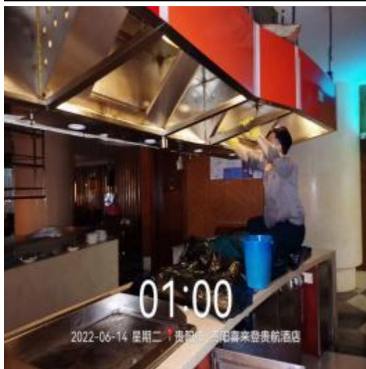
2楼明档管道顶部清洗前
