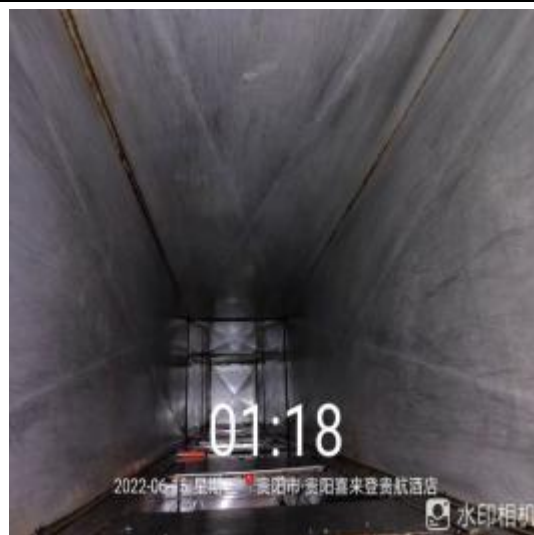
中厨房管道清洗后
