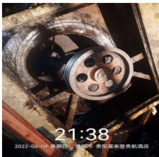
员工厨房风机机箱清洗中
