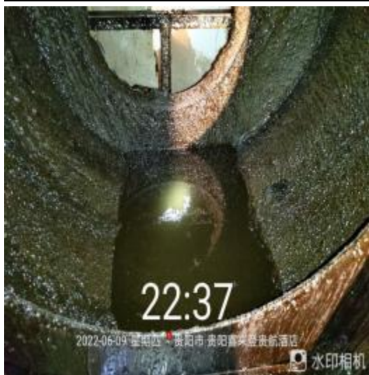
员工厨房风机机箱清洗前
