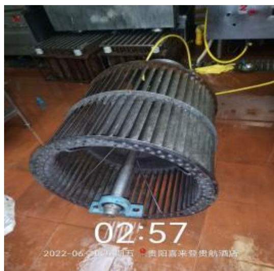
员工厨房风机清洗后
