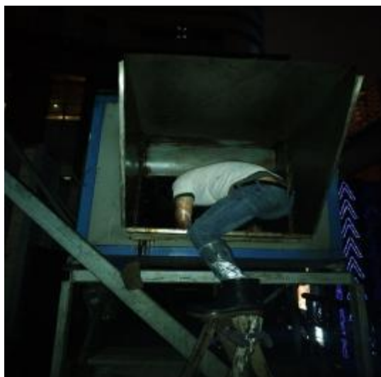
3楼平台风机施工中
