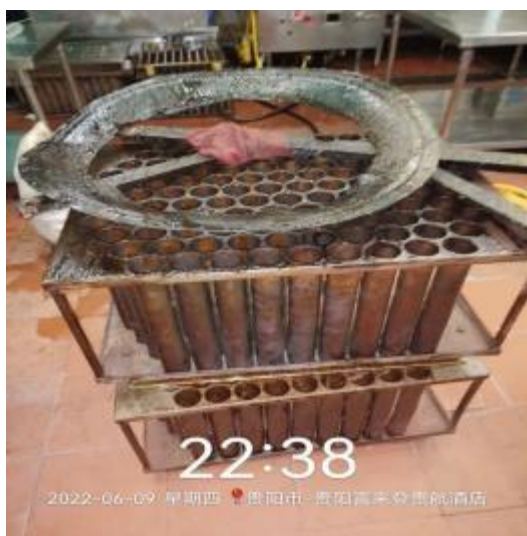
员工厨房净化器清洗前
