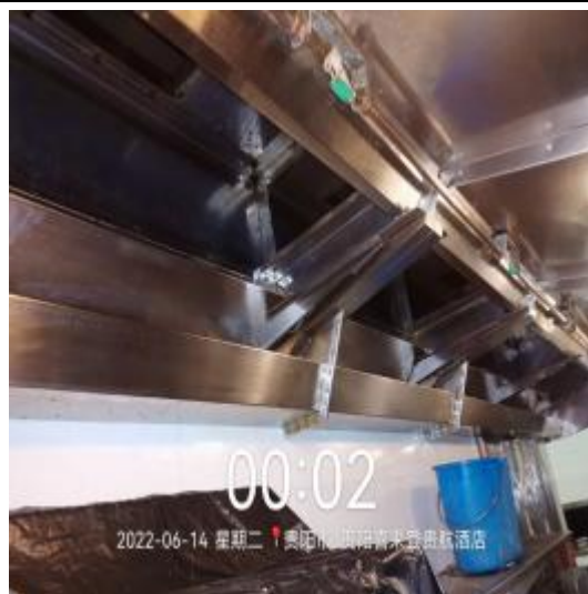
西厨房烟罩清洗后
