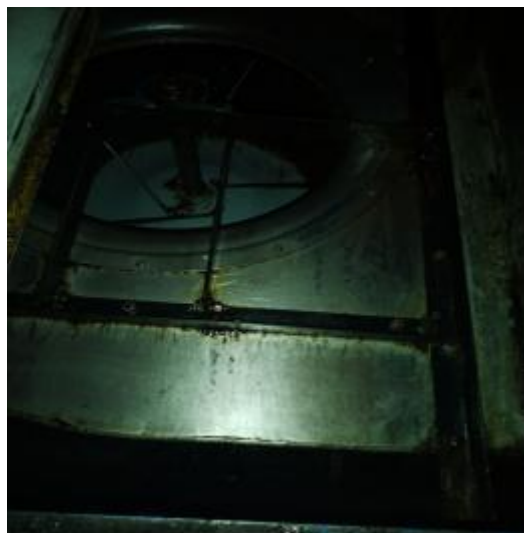
3楼平台风机清洗后 2
