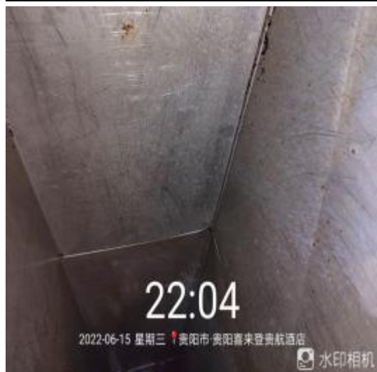
烧腊房管道洗前
