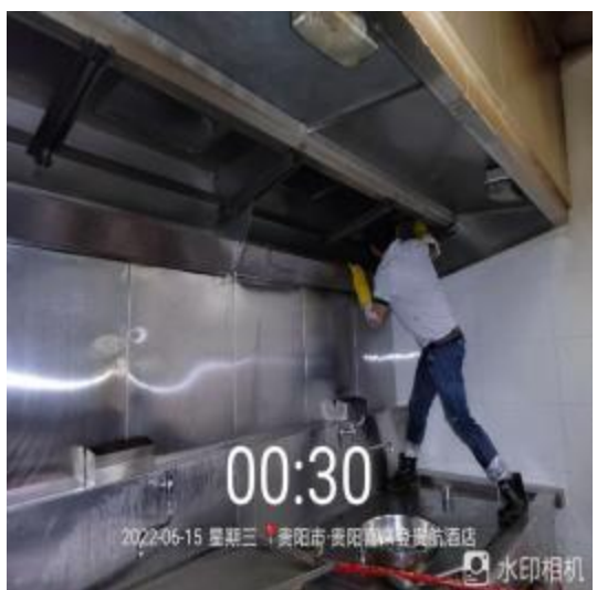
中厨房烟罩施工中
