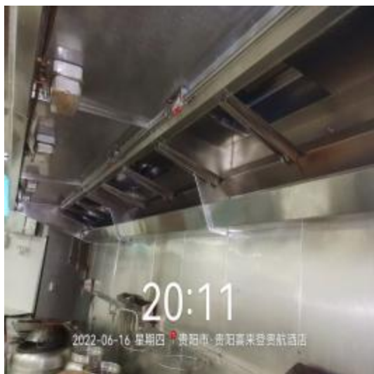
宴会厨房烟罩清洗前
