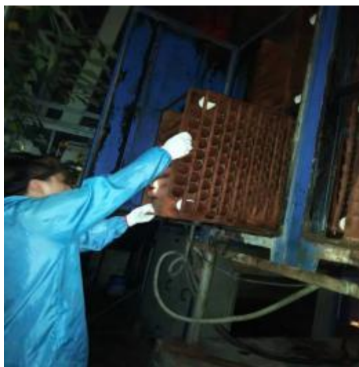
3楼平台净化器施工中
