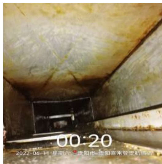
员工厨房管道清洗后
