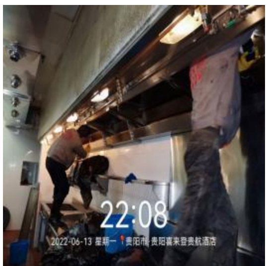
西厨房烟罩清洗中
