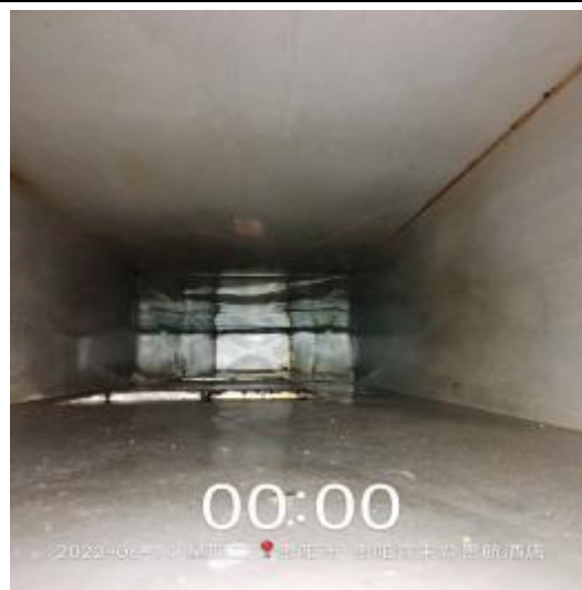
西厨房管道清洗后
