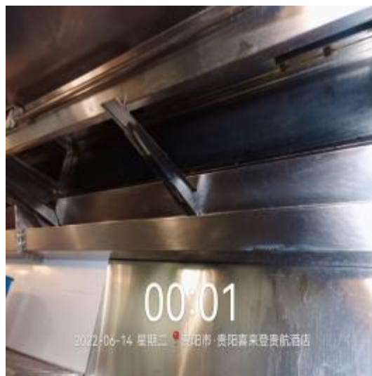
西厨房烟罩清洗后
