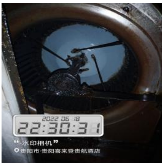
3楼平台风机清洗后 1
