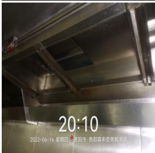
宴会厨房烟罩清洗前 2
