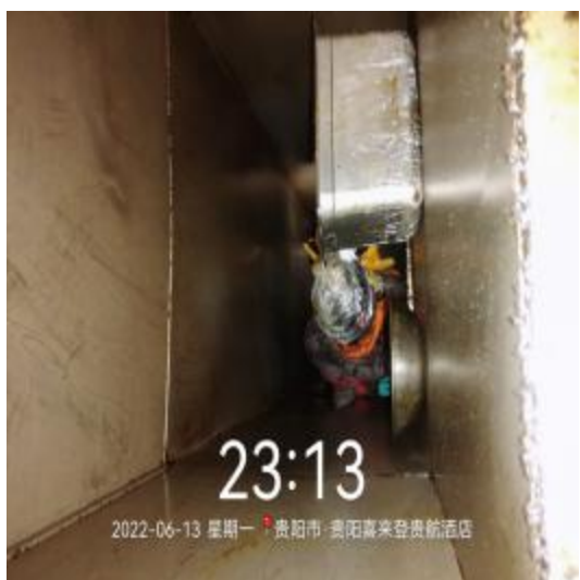
西厨房管道清洗中
