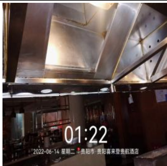
2楼明档管道顶部清洗后
