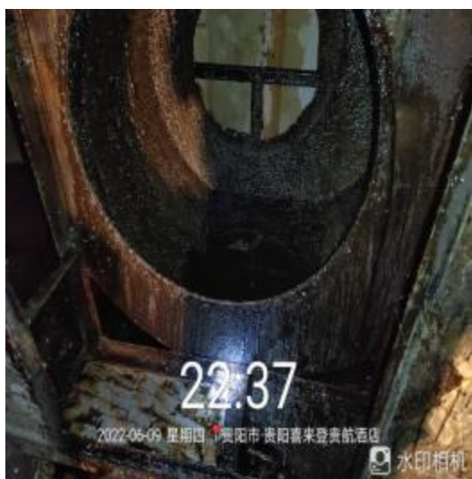
员工厨房风机机箱清洗中
