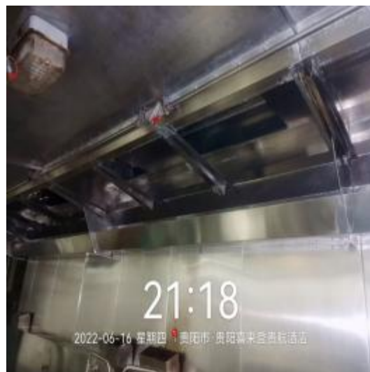
宴会厨房烟罩施工中
