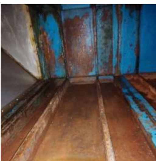
3楼平台净化器机箱清洗后
