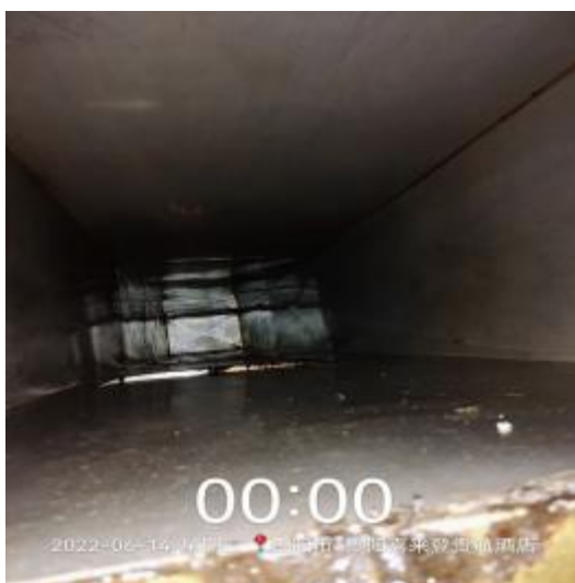
西厨房管道清洗后
