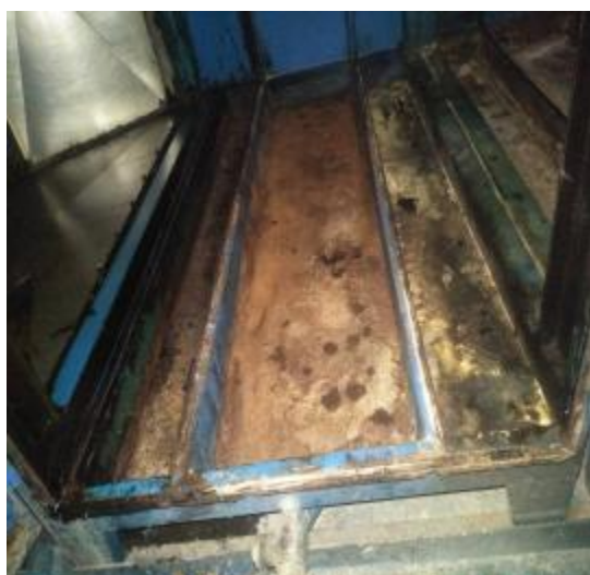
三楼净化器内部清洗后
