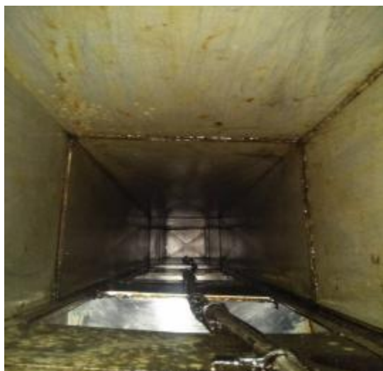
中厨房管道清洗前
