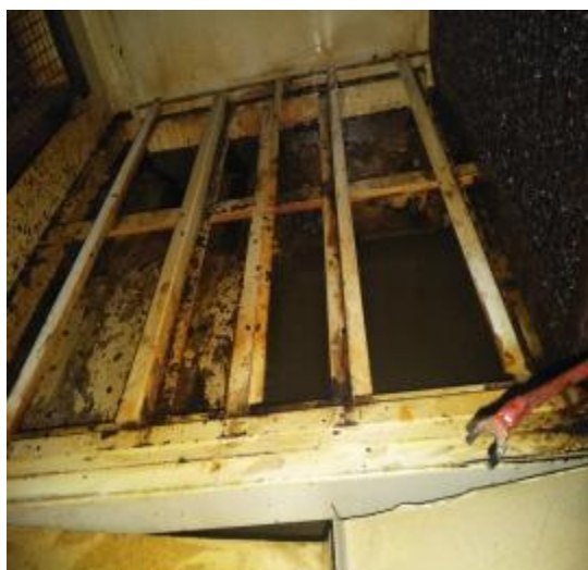
38楼净化器内部清洗前
