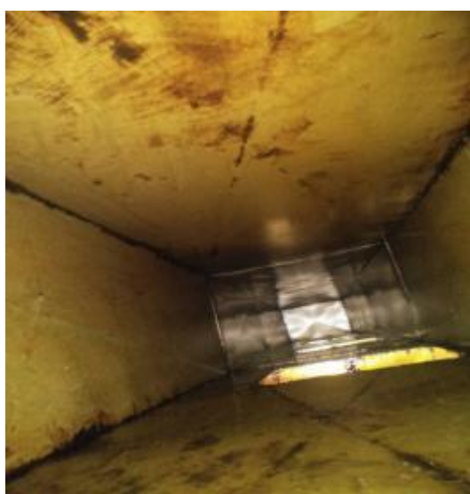
西厨房管道清洗前
