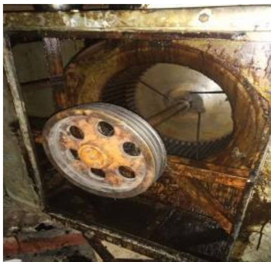
三楼风机清洗前 2
