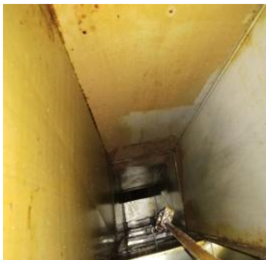
宴会厨房管道清洗前
