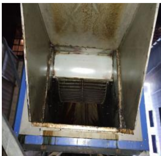
三楼风机清洗前 3
