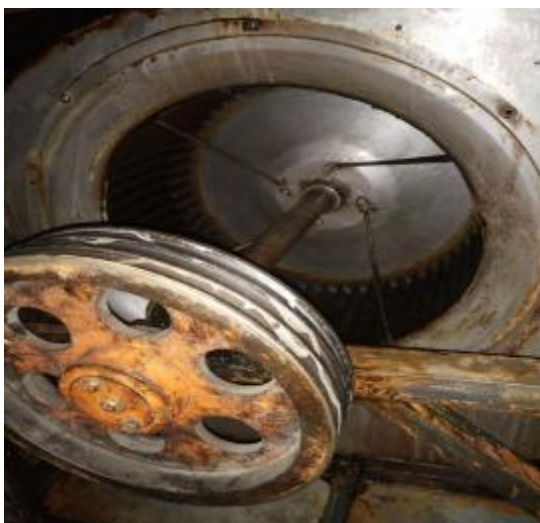
三楼风机清洗后 2
