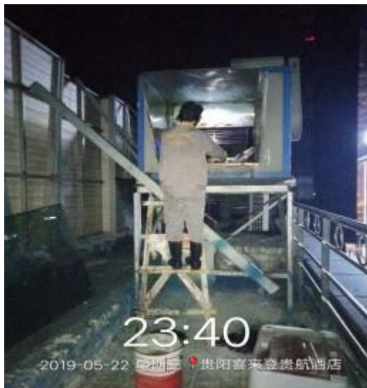
三楼风机施工
