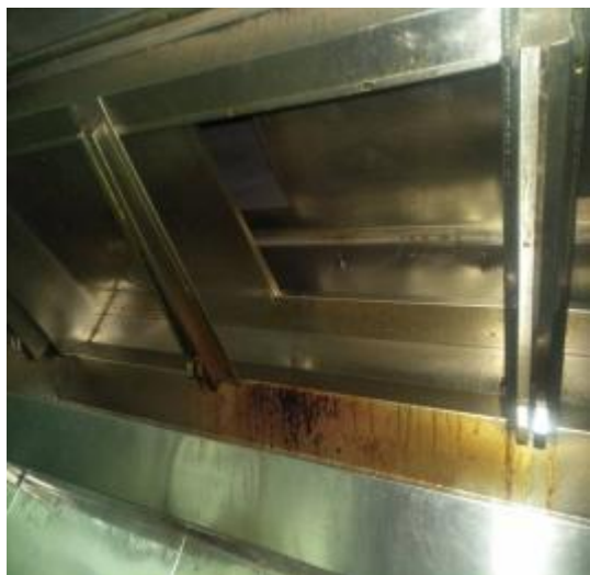
宴会厨房烟罩清洗前
