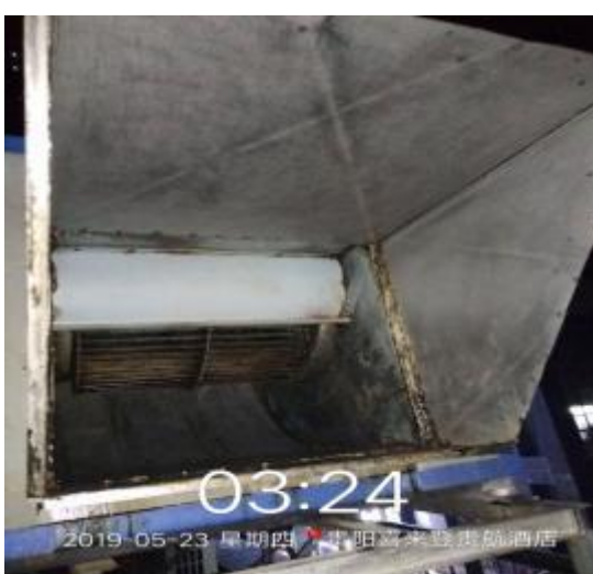
三楼风机清洗后 3
