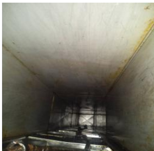
中厨房管道清洗后
