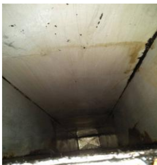
西厨房管道清洗后
