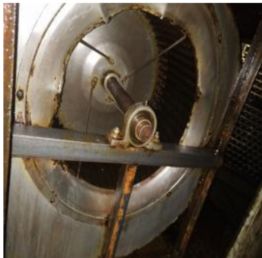
三楼平台风机清洗后 1
