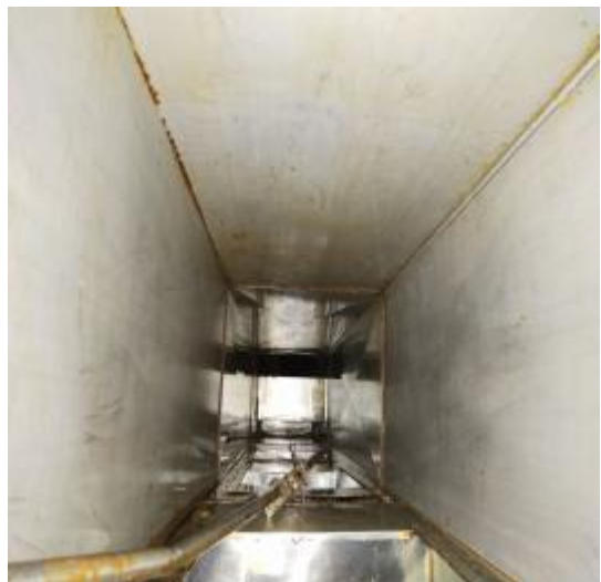
宴会厨房管道清洗后
