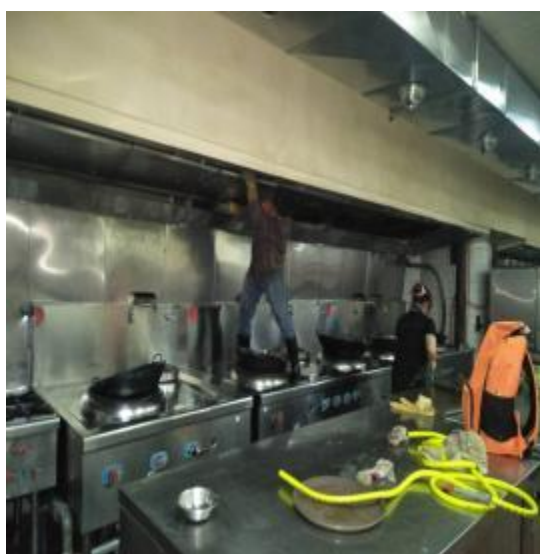
中厨房烟罩施工
