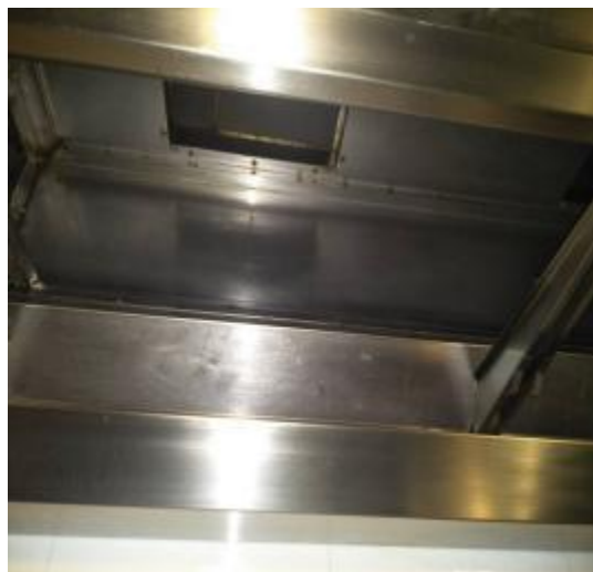
38 楼烟罩施工中
