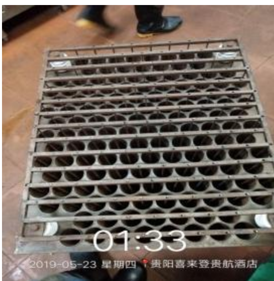
员工厨房净化器清洗后
