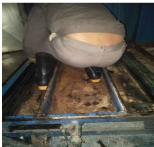
三楼净化器内部施工
