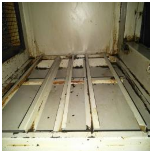
38楼净化器内部清洗后
