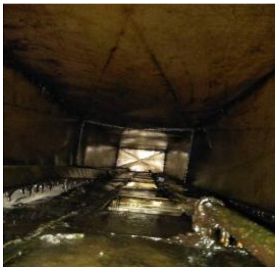
员工厨房管道清洗前
