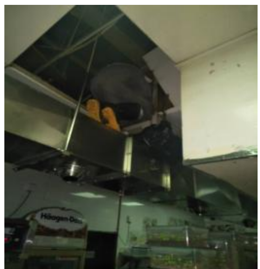
38 楼净化器施工
