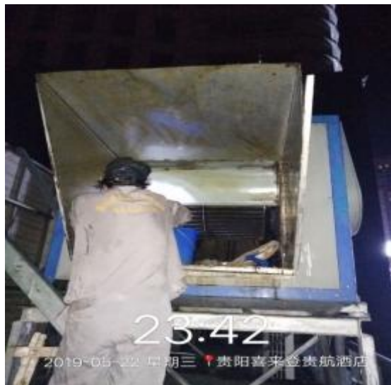
三楼风机施工
