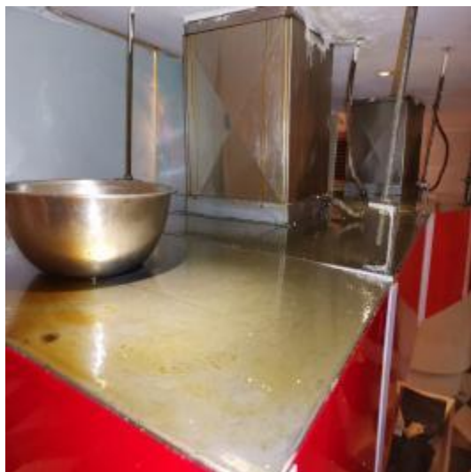
2 楼明档管道顶部清洗前
