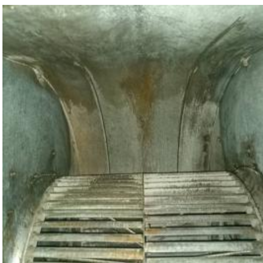
3 楼平台风机清洗后 2
