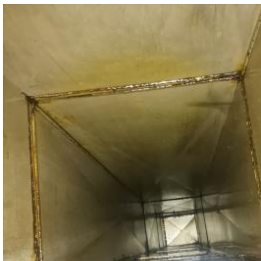
烧腊肉房管道清洗前
