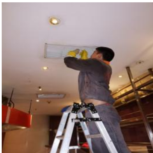
2 楼明档出风口施工中
