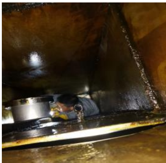
员工厨房管道施工中
