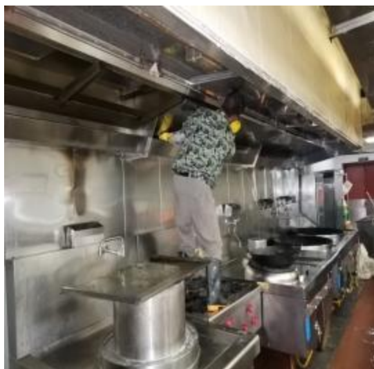
员工厨房烟罩施工中
