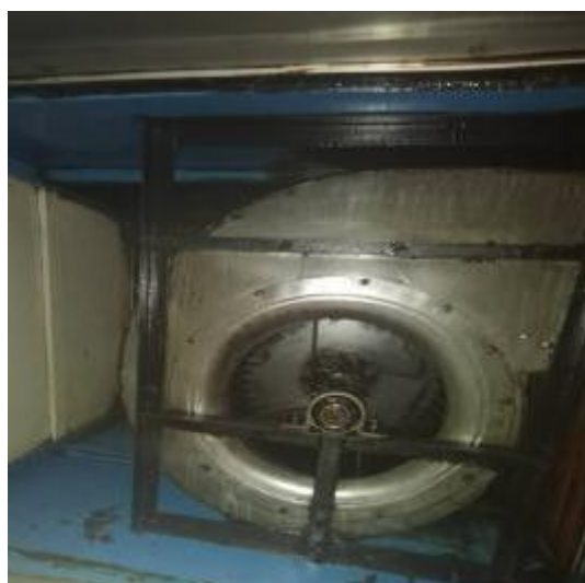
3楼平台风机清洗后 3
