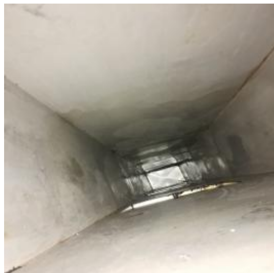
西厨房管道清洗后
