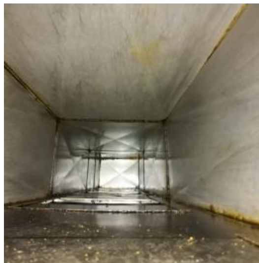
中厨房管道清洗后
