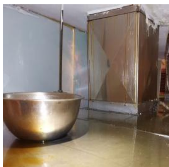
2 楼明档管施工洗中
