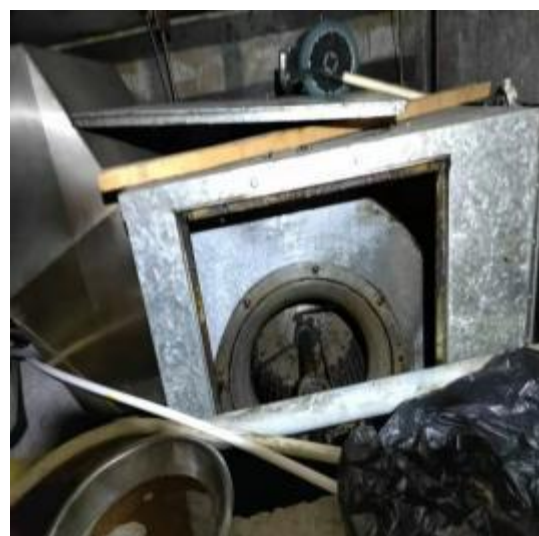
2 楼明档风机清洗后
