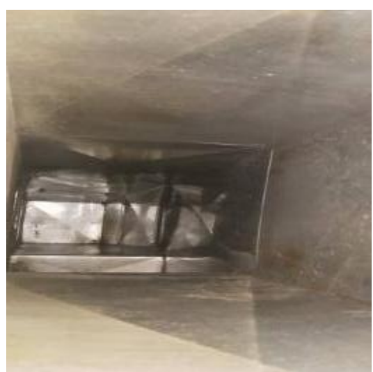
烧腊肉房管道清洗后
