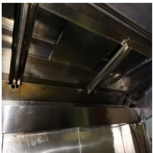
宴会厨房烟罩清洗前 2
