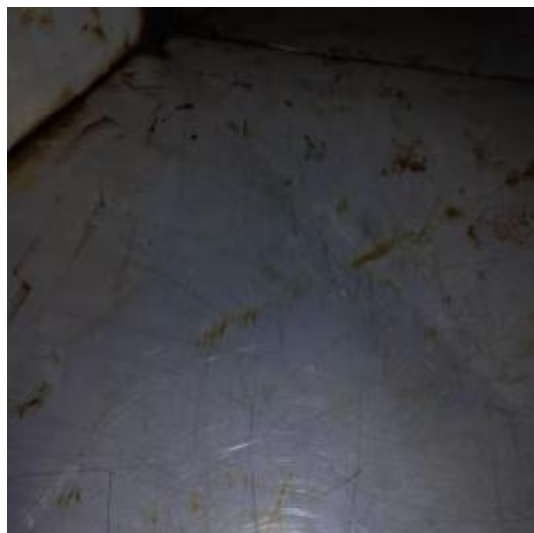
2 楼明档管道清洗后
