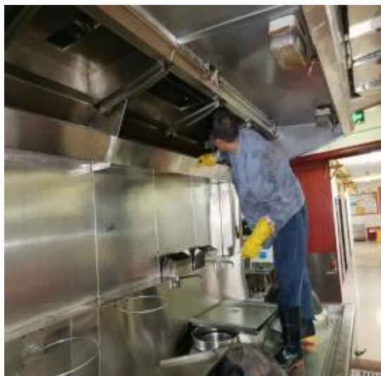
宴会厨房烟罩施工中
