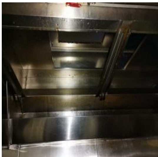
宴会厨房烟罩清洗前 1
