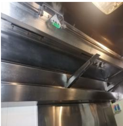
西厨房烟罩清洗后
