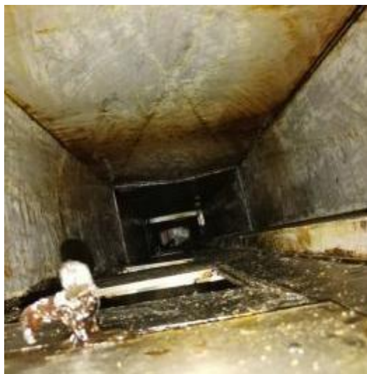
员工厨房管道清洗后
