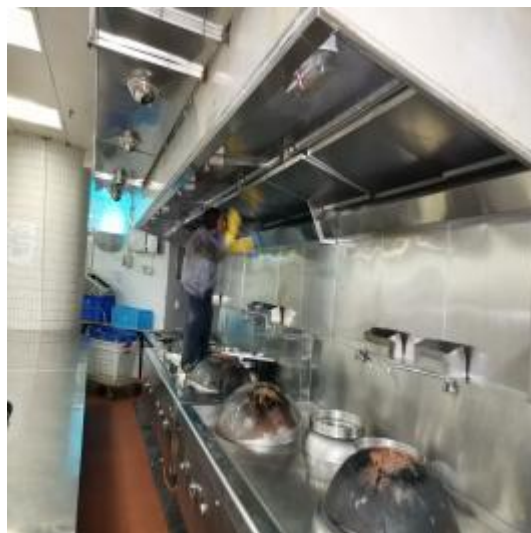
宴会厨房烟罩施工中
