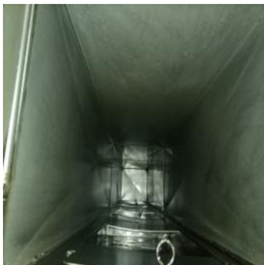
宴会厨房管道清洗后
