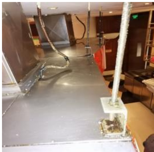
2 楼明档管道顶部清洗后
