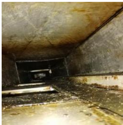
员工厨房管道清洗后
