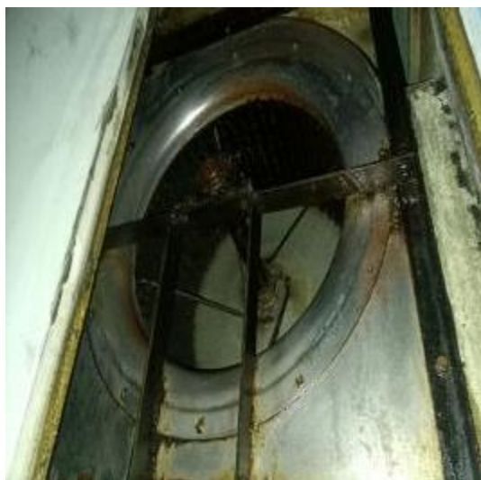
3 楼平台风机清洗后 1
