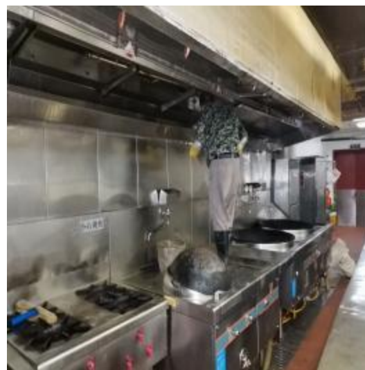
员工厨房烟罩施工中
