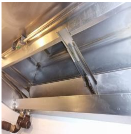
西厨房烟罩清洗后
