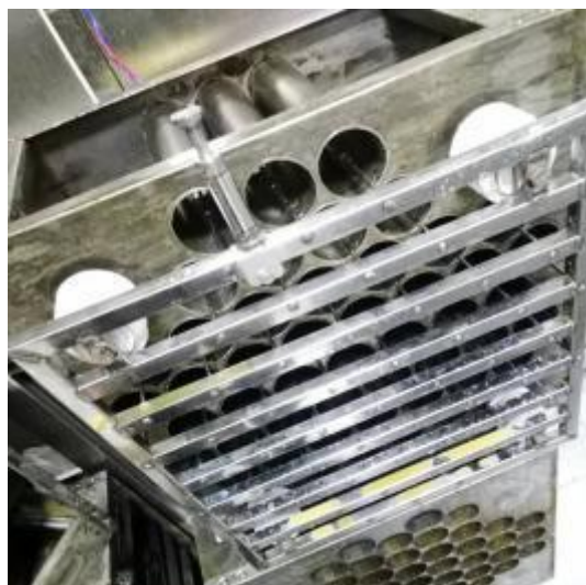
3楼平台净化器清洗后 1
