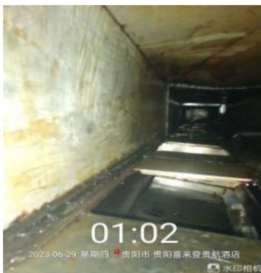
员工厨房管道清洗后
