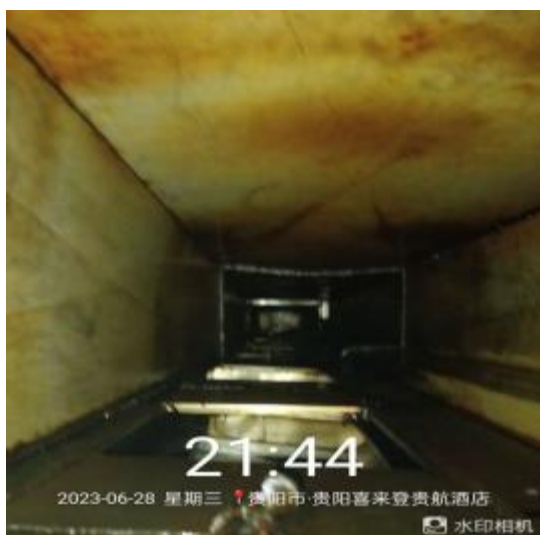
员工厨房管道清洗前
