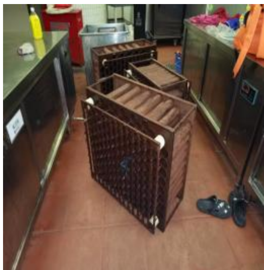
3楼平台净化器清洗中
