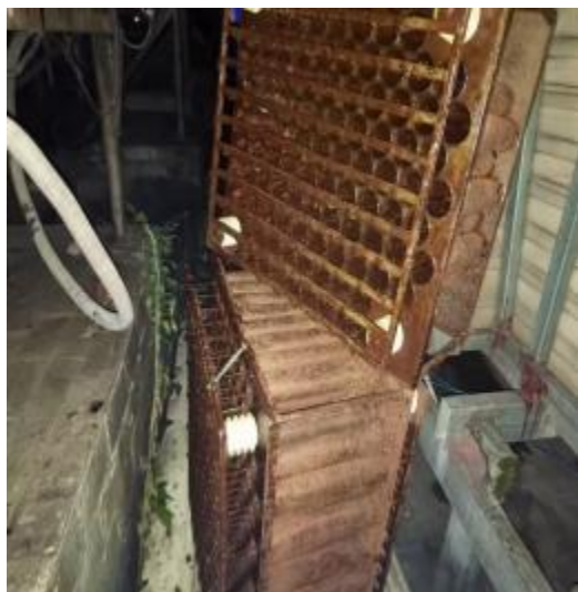
3楼平台净化器清洗中 2
