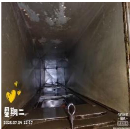
宴会厨房管道清洗前
