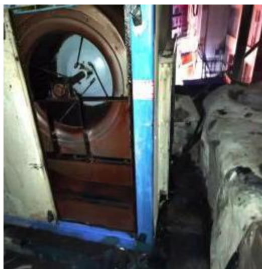
3 楼平台风机清洗后
