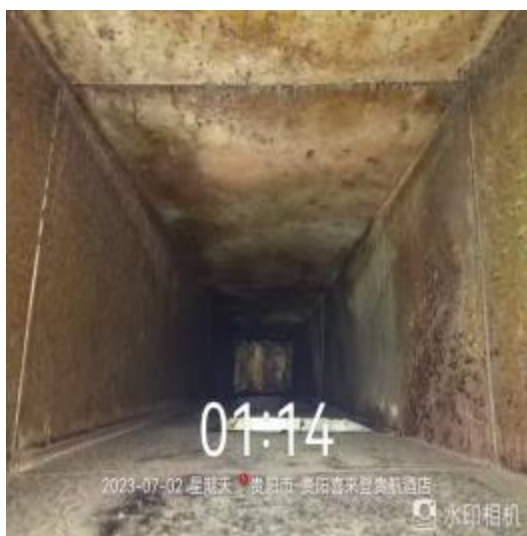
西厨房管道清洗前
