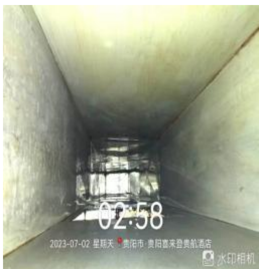
西厨房管道清洗后
