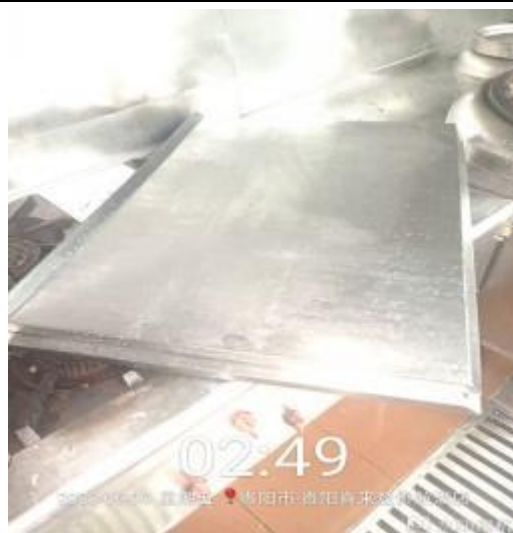
员工厨房防火板清洗后
