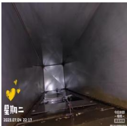
宴会厨房管道清洗前
