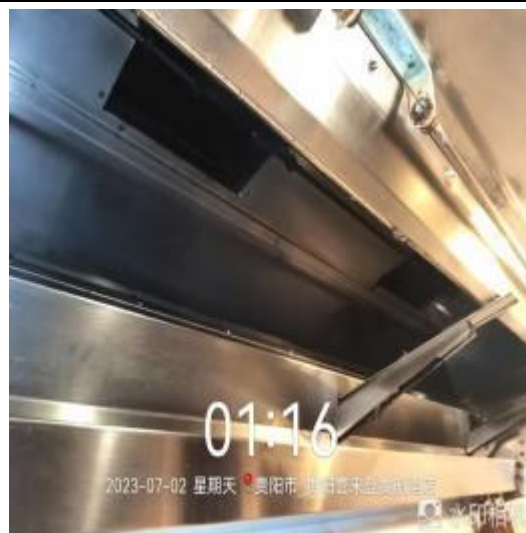
西厨房烟罩清洗后
