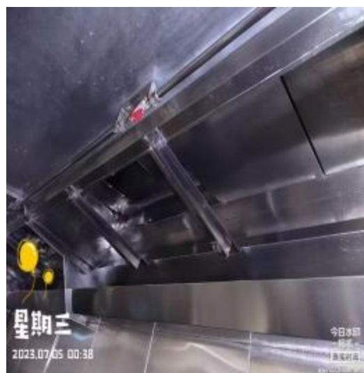
宴会厨房烟罩清洗后
