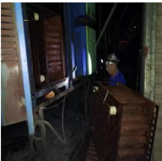
3楼平台净化器清洗中
