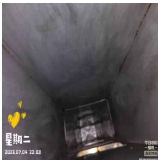
宴会厨房烟罩清洗后
