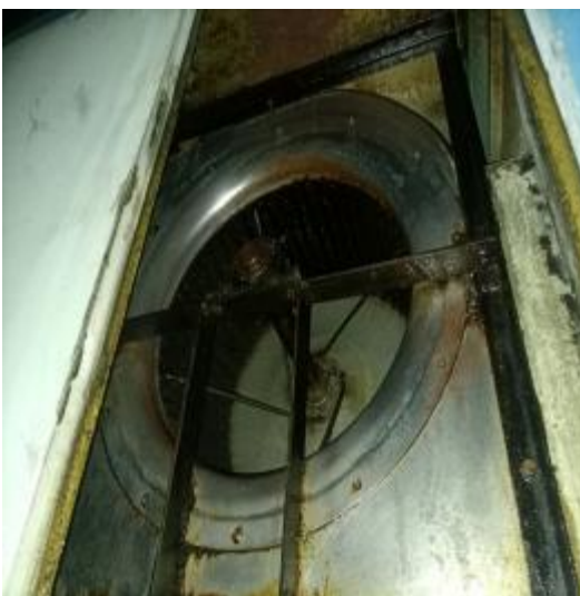
3 楼平台风机清洗后
