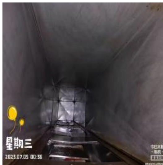
宴会厨房烟罩清洗后
