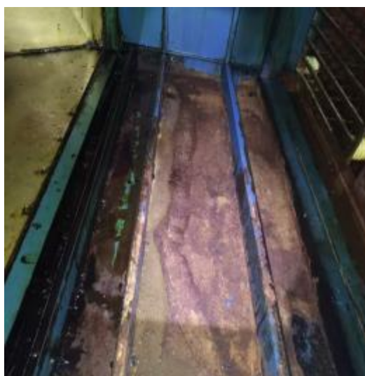
3楼平台净化器机箱清洗前
