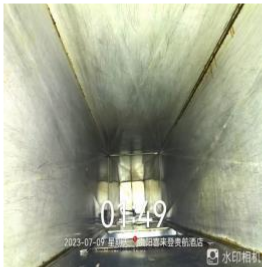
中厨房管道清洗后
