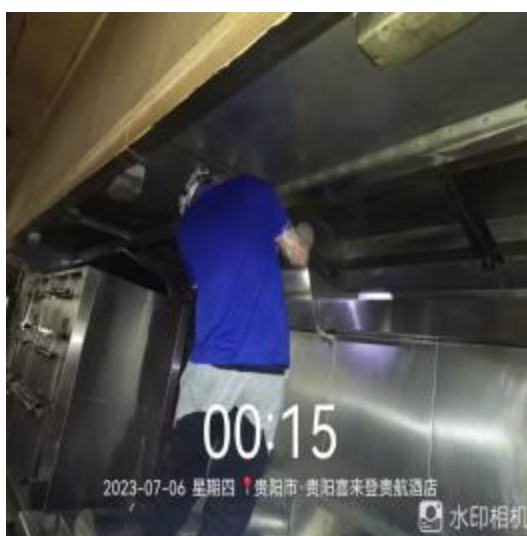
中厨房烟罩施工中
