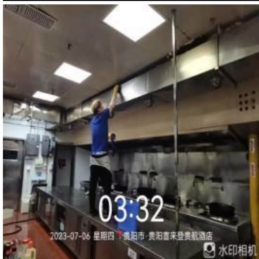
中厨房新风管清洗中
