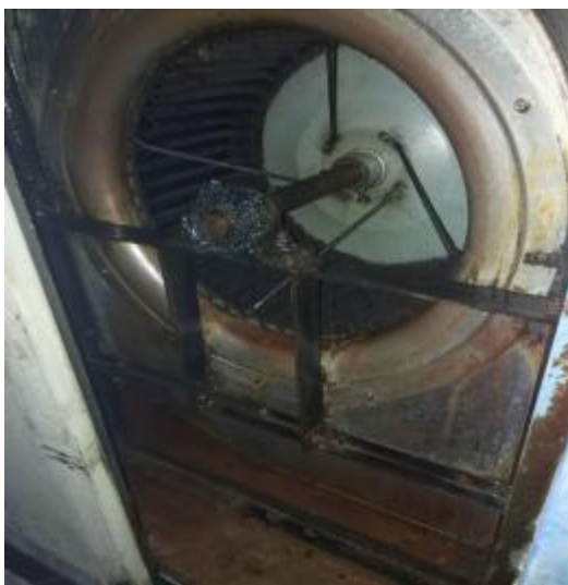
3 楼平台风机清洗后
