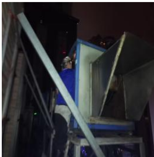
3楼平台风机清洗中
