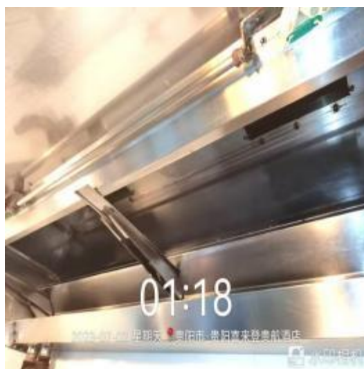
西厨房烟罩清洗后
