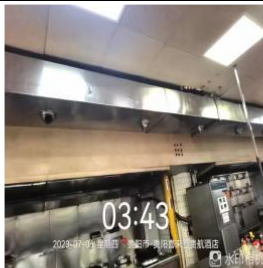
中厨房新房管清洗后
