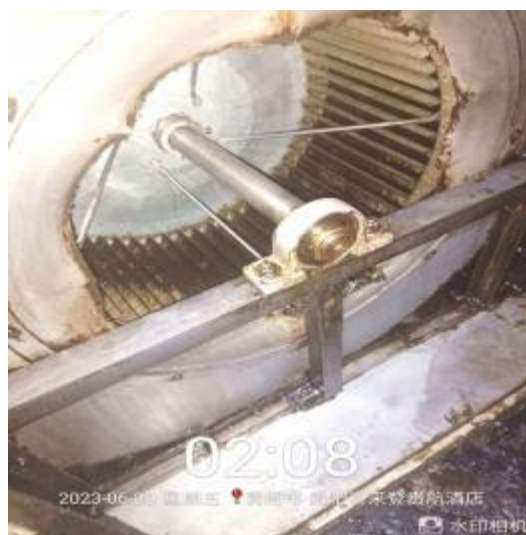
员工厨房风机清洗后
