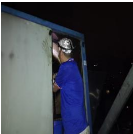
3楼平台风机清洗中
