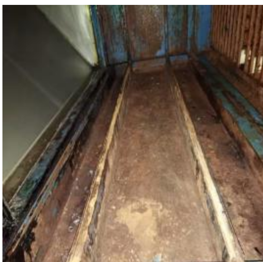
3楼平台净化器机箱清洗后
