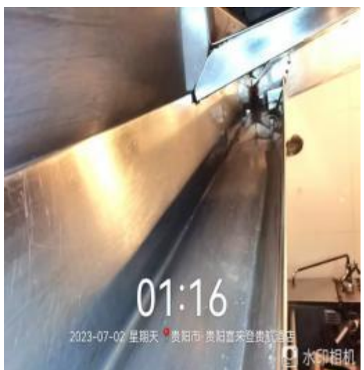
西厨房烟罩清洗后
