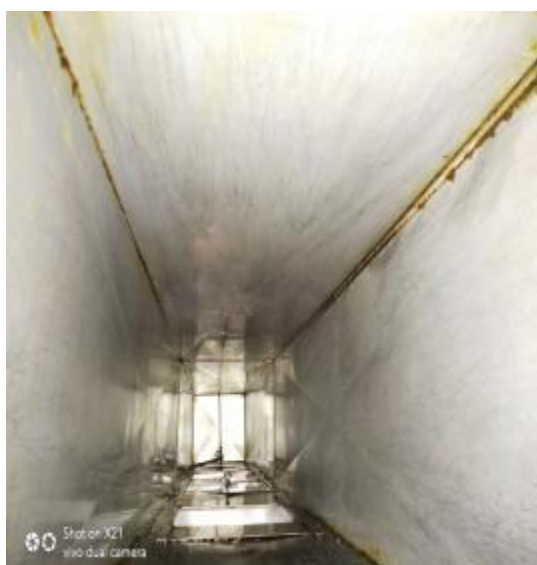
中厨房管道清洗后
