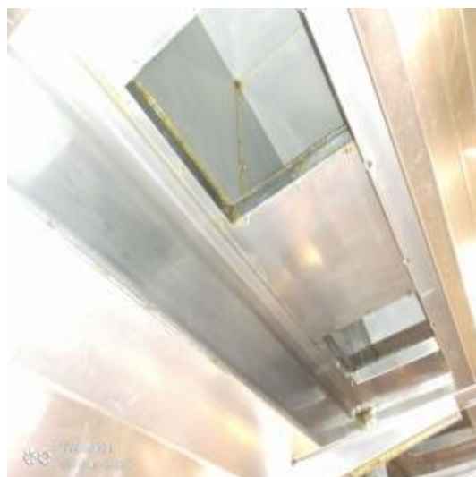
38 楼管道清洗后 2
