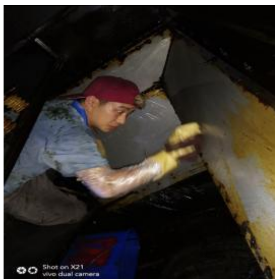
3楼平台管道施工 2
