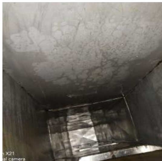
西厨房管道清洗后
