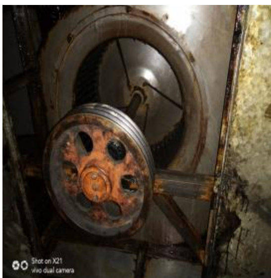
3楼平台风机清洗后 1
