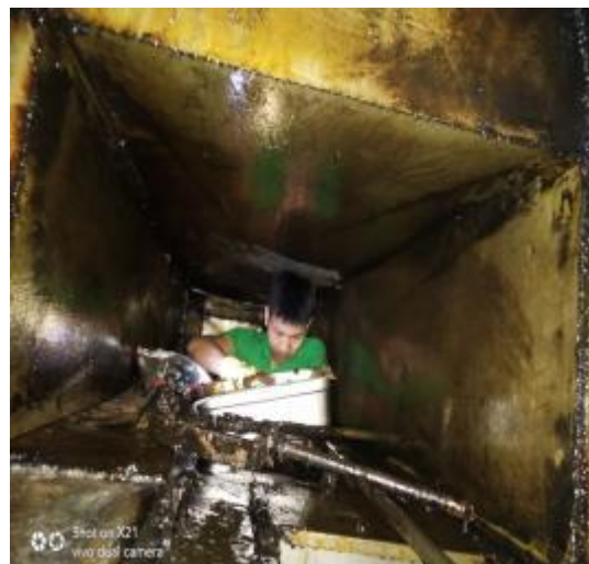
员工厨房管道施工
