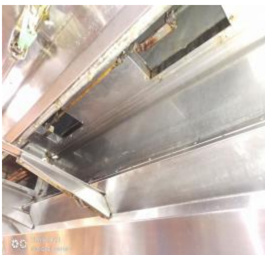
西厨房烟罩清洗后
