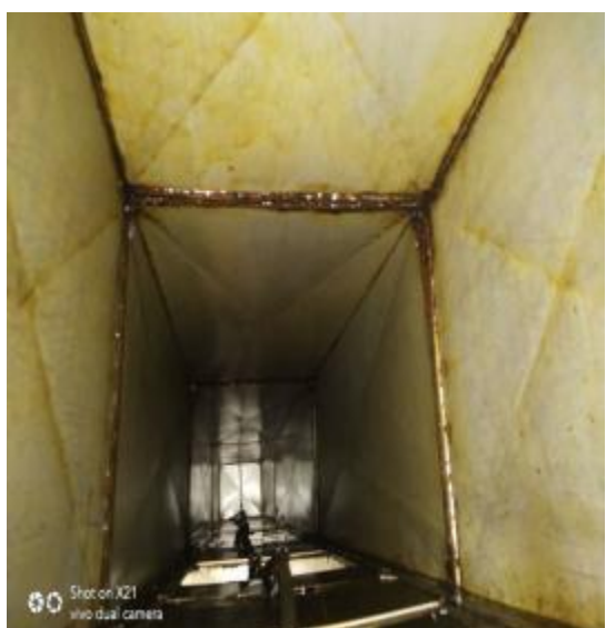
中厨房管道清洗前
