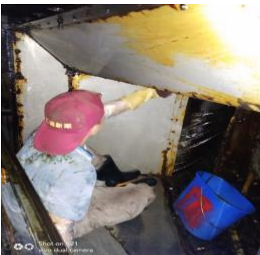
3楼平台净化器施工 2
