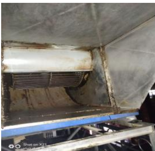
3楼平台风机清洗后 6
