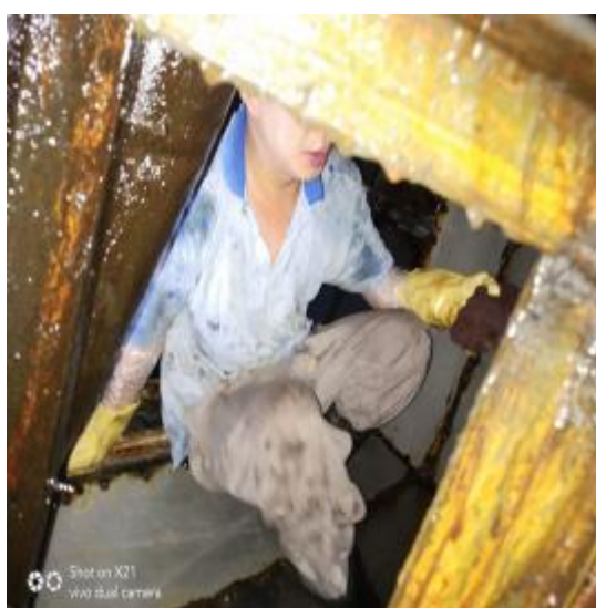
3楼平台管道施工 1
