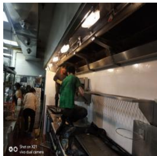
西厨房烟罩施工 2
