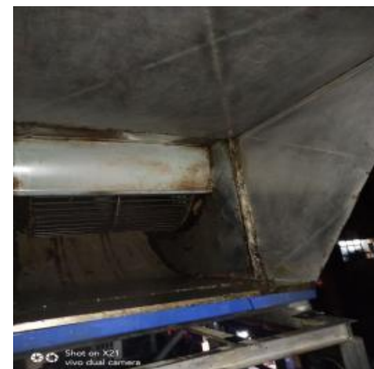
3楼平台风机清洗后 7
