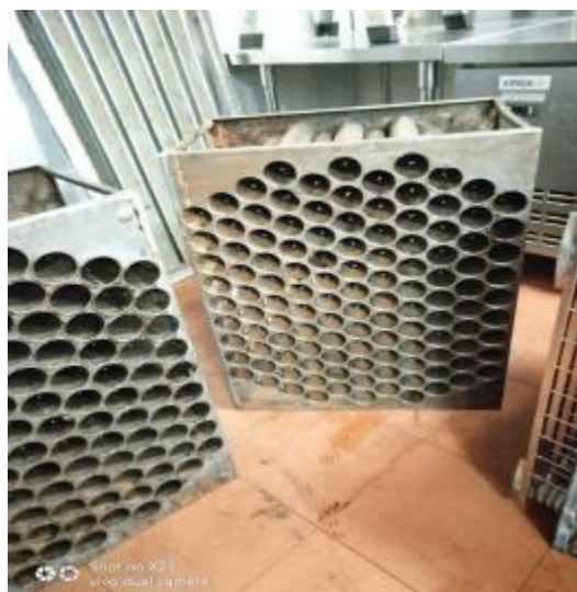
3楼平台净化器清洗后
