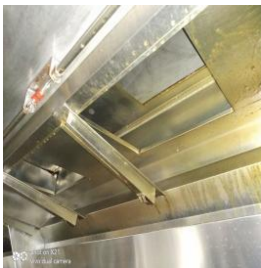
宴会厨房烟罩清洗前
