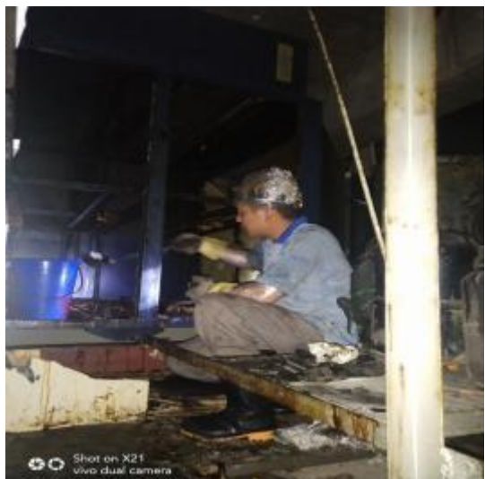
3楼平台净化器施工 3
