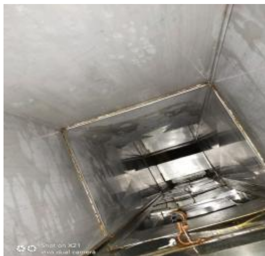
宴会厨房管道清洗后
