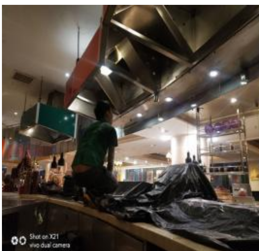
明档烟罩施工 2
