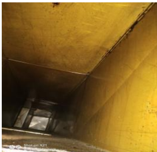
烧烤房管道清洗前
