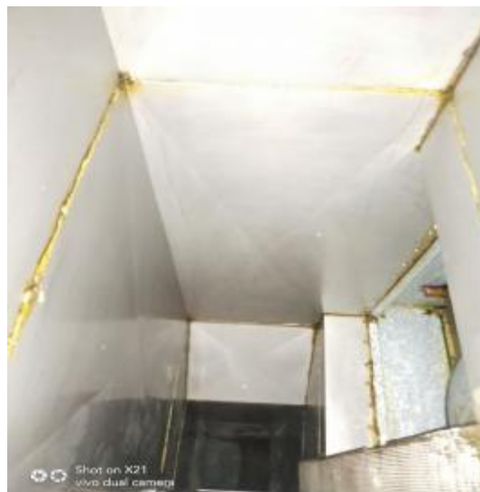
38楼管道清洗后
