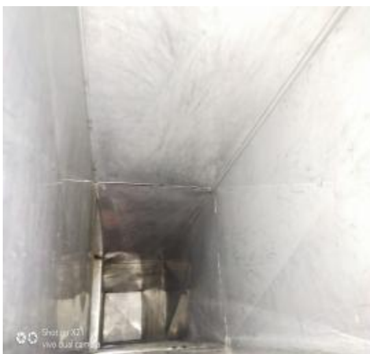
烧烤房管道清洗后
