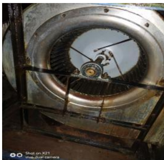
3楼平台风机清洗后 5
