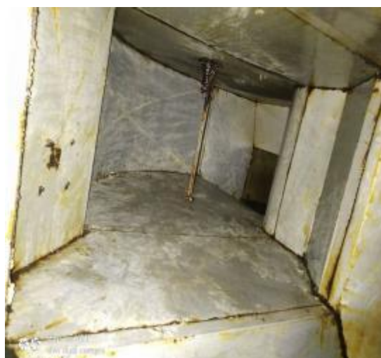
3楼平台管道清洗后
