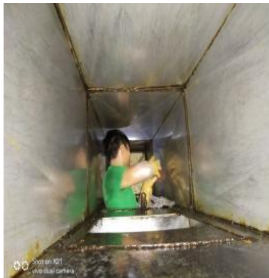
中厨房管道施工
