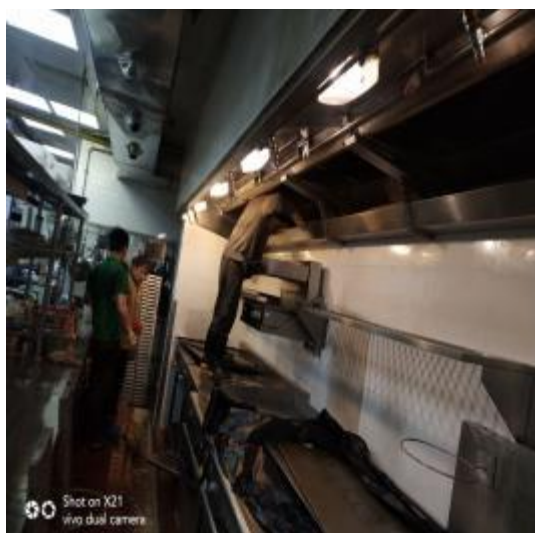
西厨房烟罩施工 1
