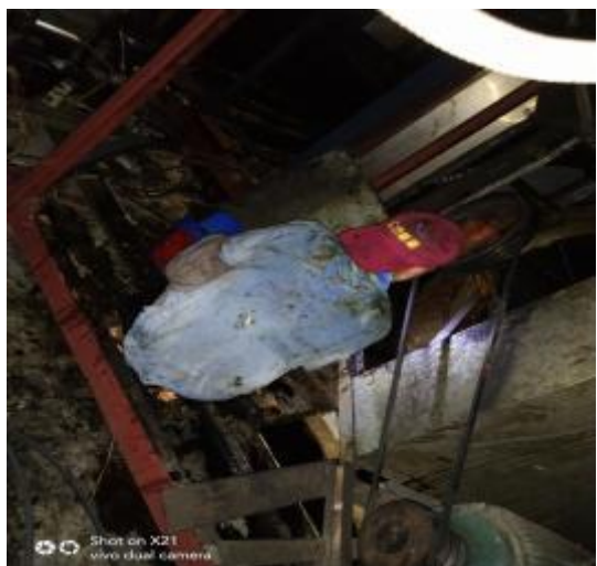
3楼平台净化器施工 1
