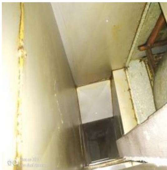
38楼管道清洗前
