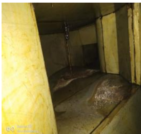
3楼平台管道清洗前
