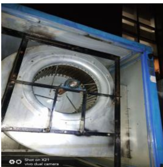
3楼平台风机清洗后 4
