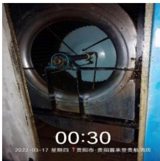
3楼平台风机清洗后 1
