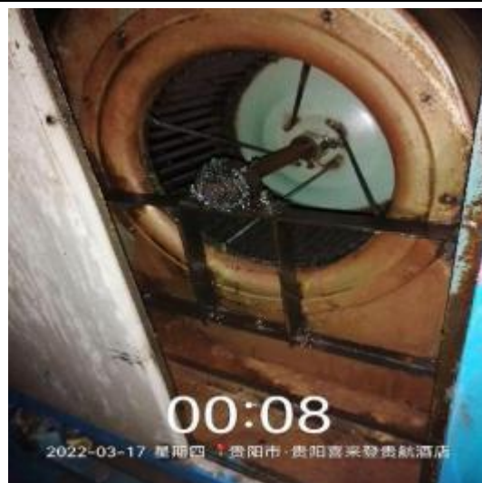
3楼平台风机清洗后3
