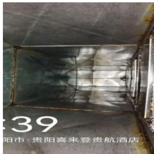
西厨房管道清洗后
