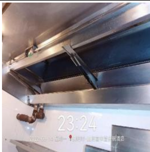
西厨房烟罩清洗后
