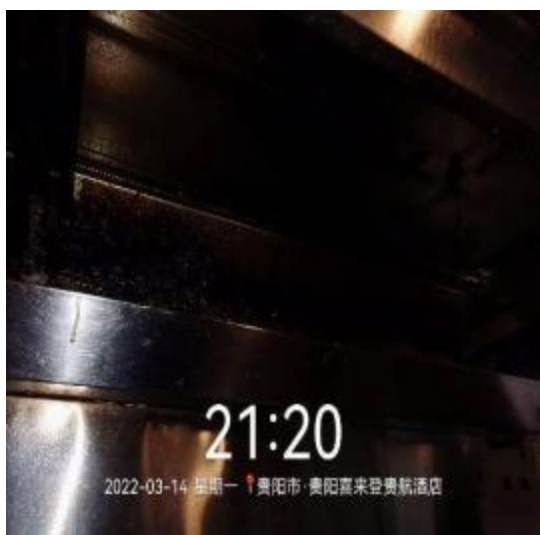
西厨房烟罩清洗前
