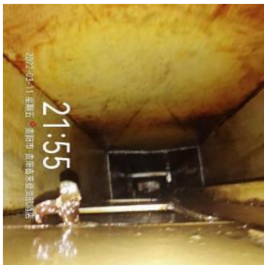
员工厨房管道清洗前
