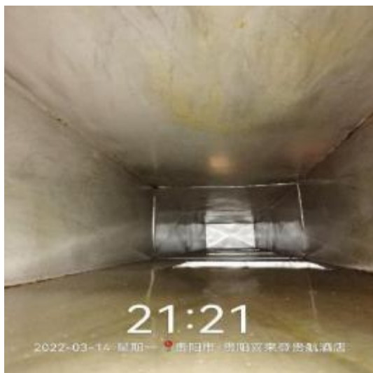
西厨房管道清洗前
