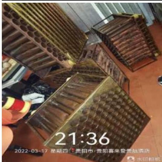
员工厨房净化器清洗前
