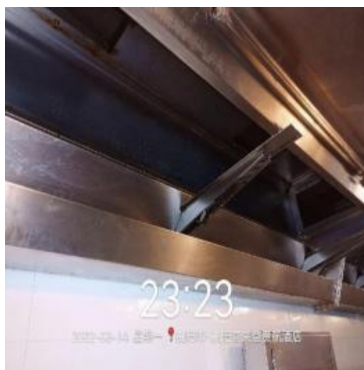
西厨房烟罩清洗后
