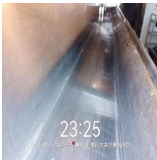
西厨房烟罩清洗后
