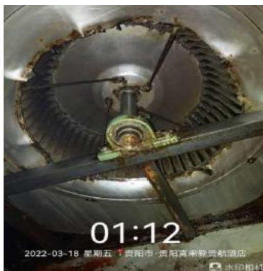
员工厨房风机清洗后
