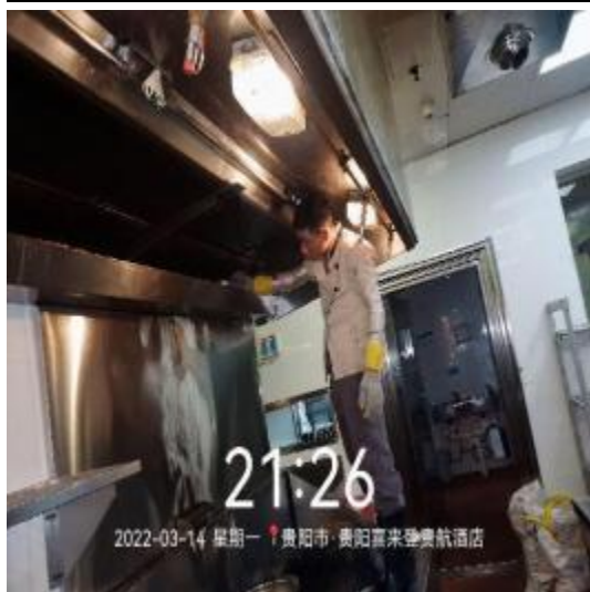
西厨房烟罩清洗中
