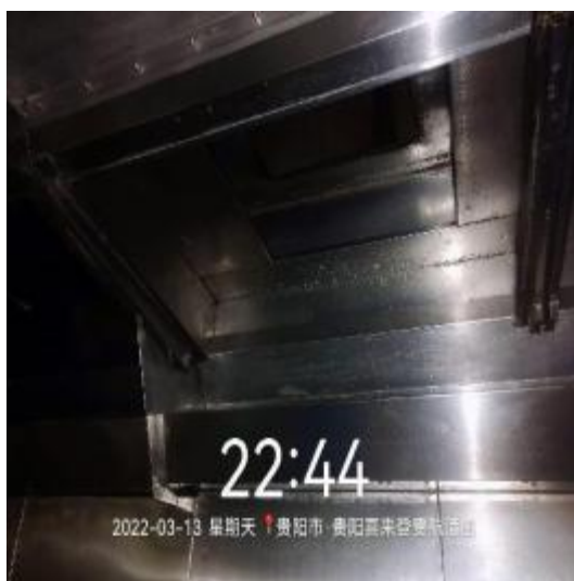
宴会厨房管道清洗后
