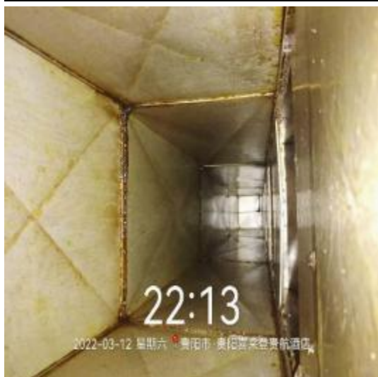
中厨房管道清洗前
