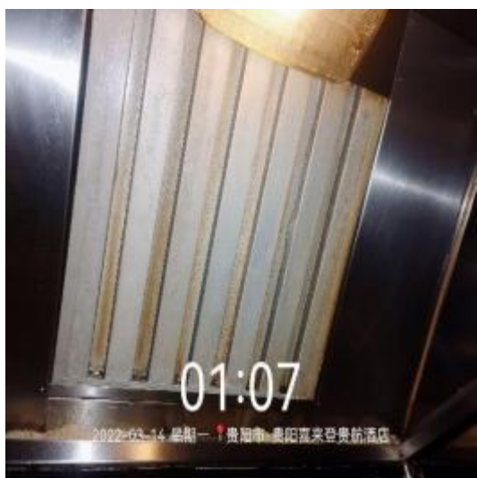
2楼明档防火板清洗前
