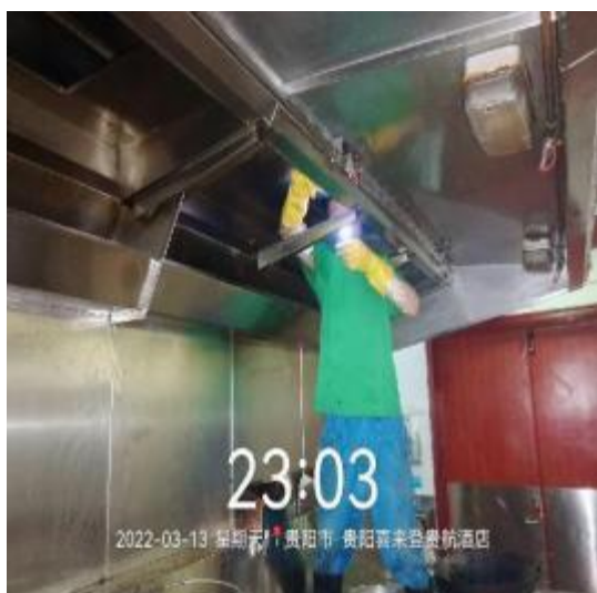
宴会厨房烟罩施工中
