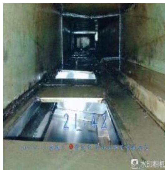
员工厨房管道清洗后
