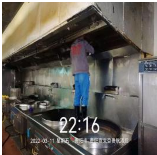
员工厨房烟罩施工中
