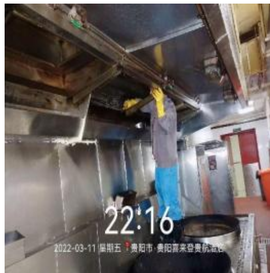
员工厨房烟罩施工中
