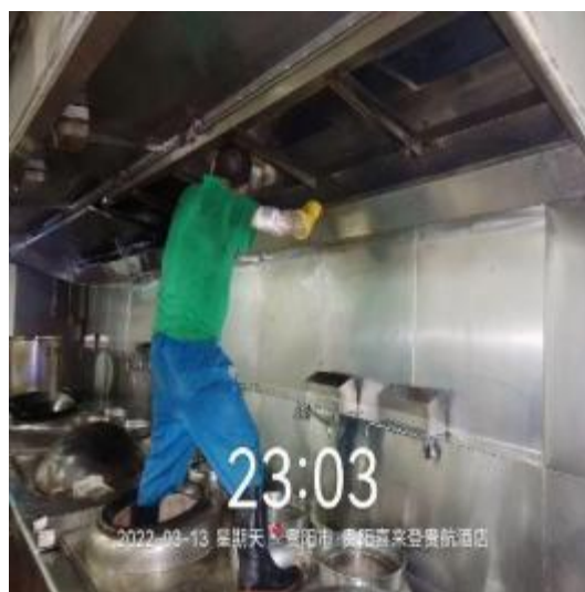
宴会厨房烟罩施工中
