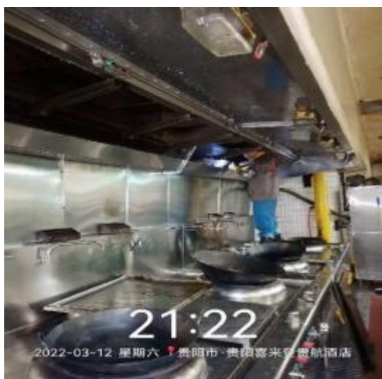
中厨房烟罩施工中
