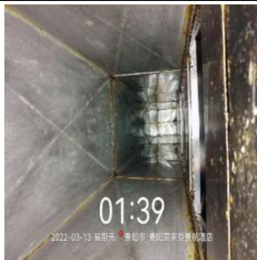
中厨房管道清洗后
