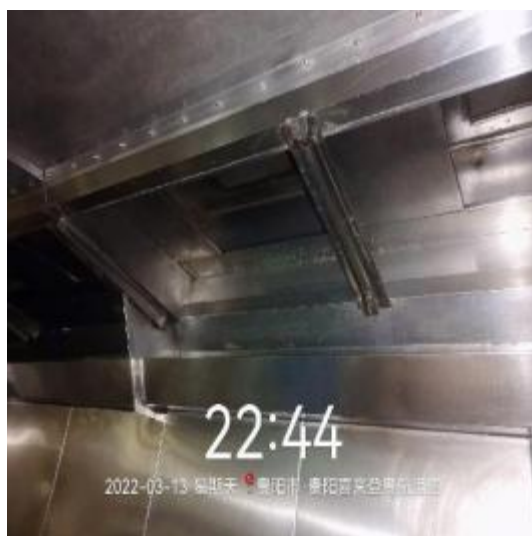
宴会厨房烟罩清洗后 1
