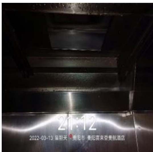
宴会厨房管道清洗前
