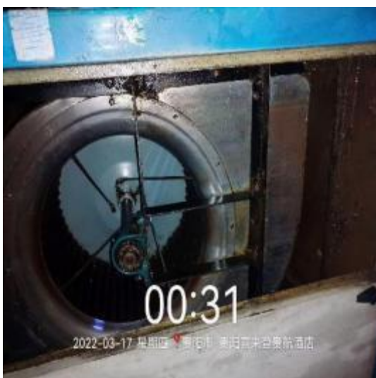
3楼平台风机清洗后 2
