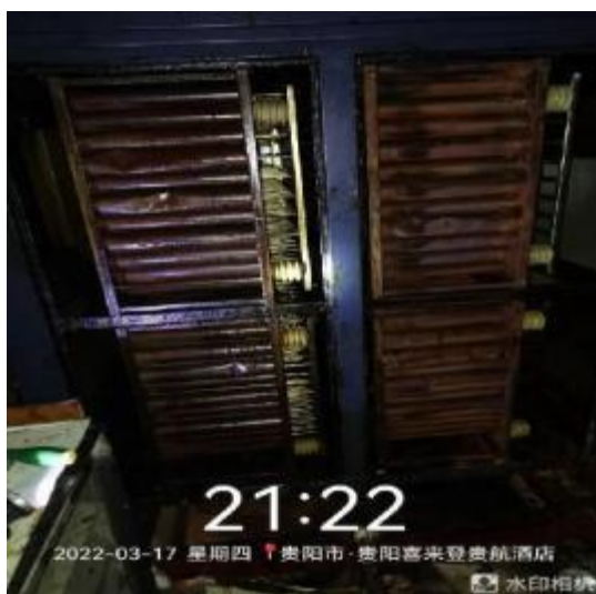
员工厨房净化器施工中
