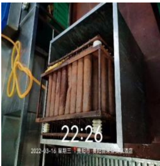
3楼平台净化器施工中
