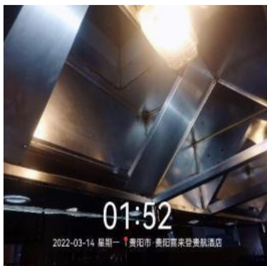
2楼明档管道顶部清洗后
