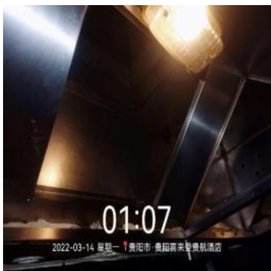
2楼明档管道顶部清洗前
