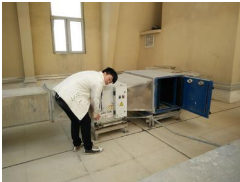
净化器施工中
