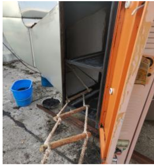
垂直管道施工中
