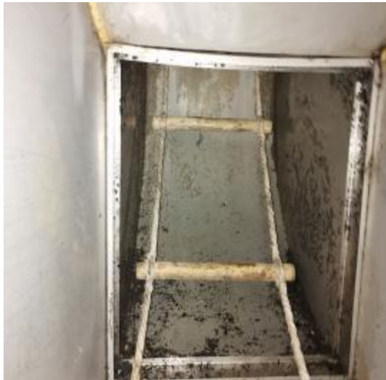
垂直管道清洗前 2
