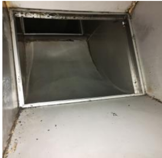
垂直管道清洗后 2
