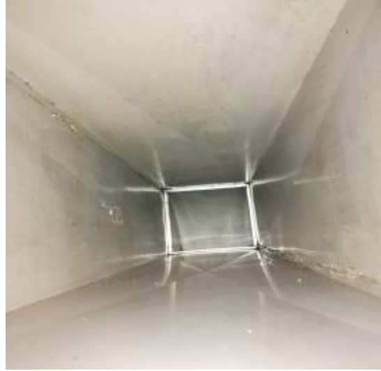
垂直管道清洗后 1
