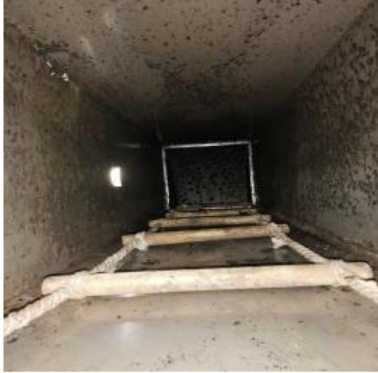
垂直管道清洗前 1
