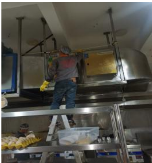
净化器施工中
