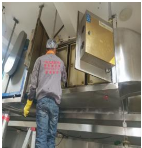
净化器施工中
