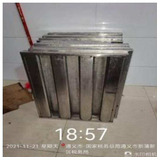
防火板清洗后
