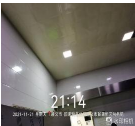
厨房天花板清洁前
