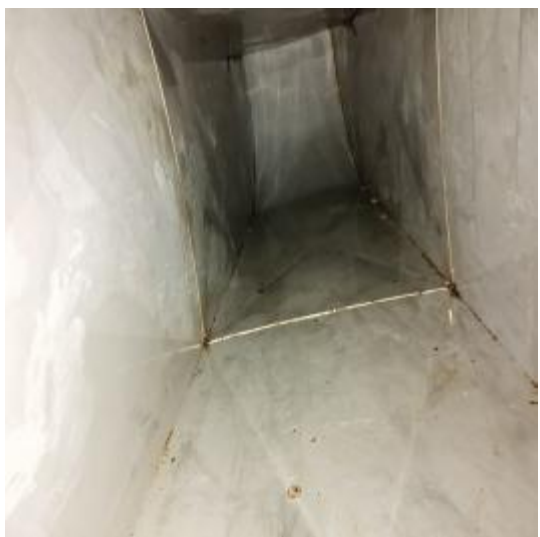
主管道清洗后 2
