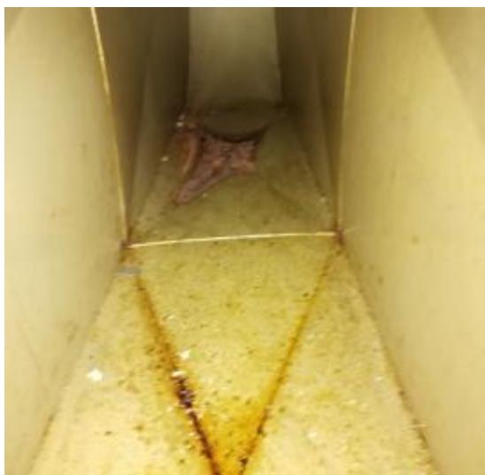
主管道清洗前 2
