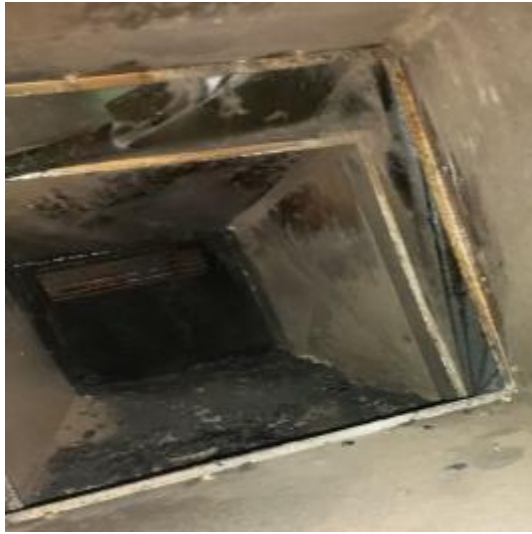
楼顶管道清洗前
