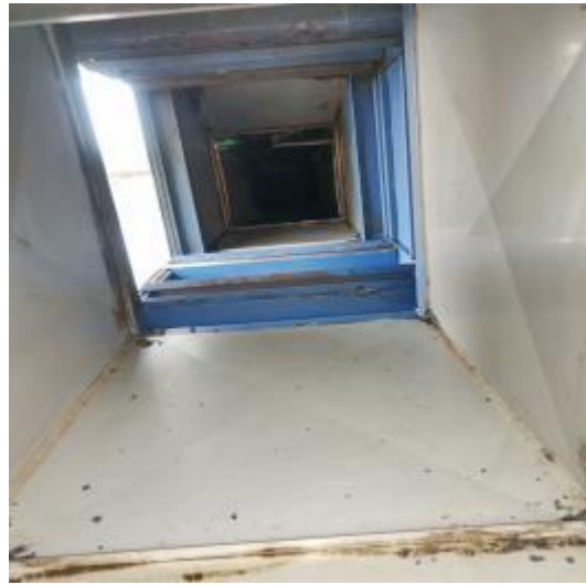
楼顶管道清洗后
