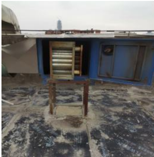
净化器施工中前
