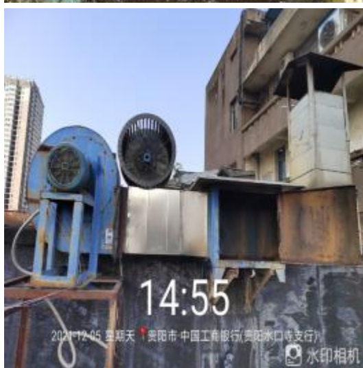
风机箱施工中
