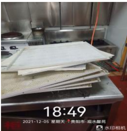
天花板清洗中
