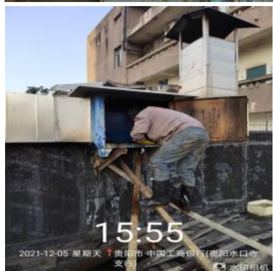
净化器机箱施工中
