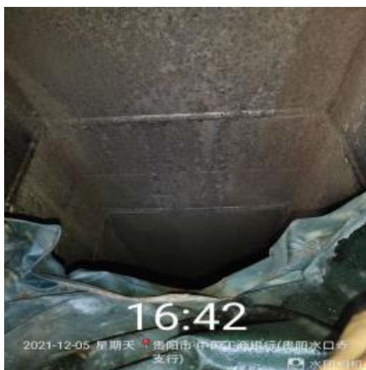
楼顶竖管道清洗前
