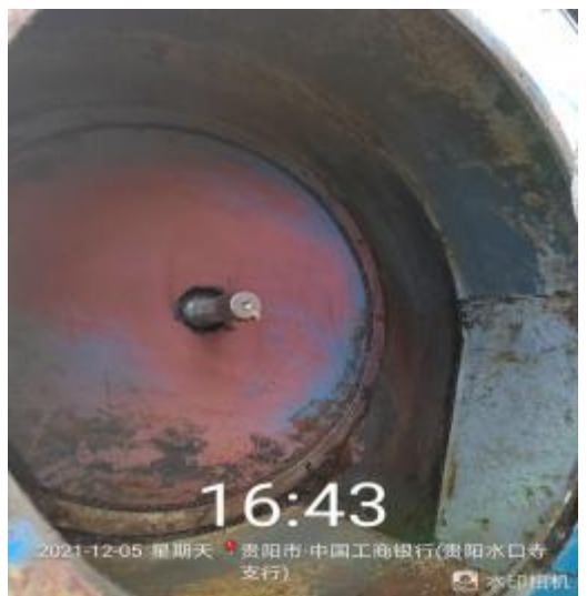
风机机箱清洗后
