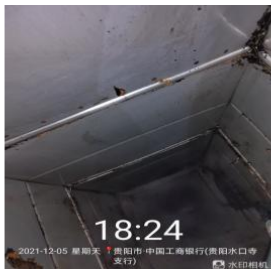
楼顶竖管道清洗后
