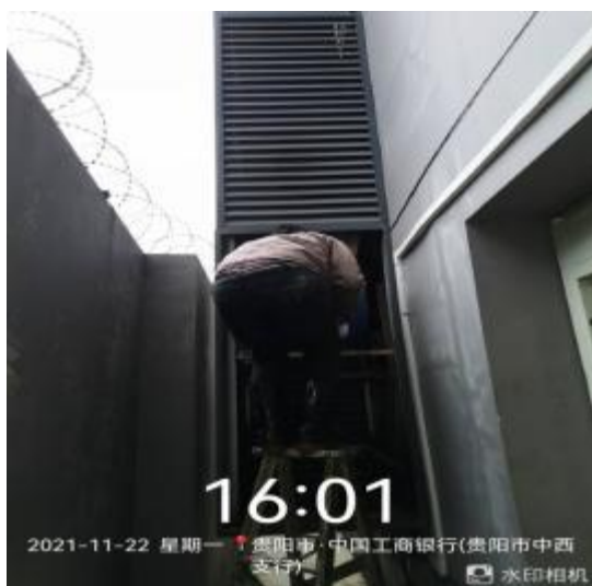
外墙管道施工中
