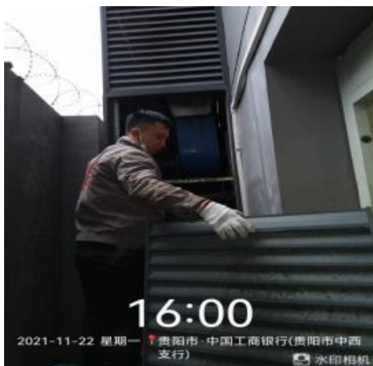
外墙管道施工
