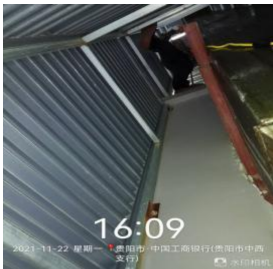
外墙管道清洗后
