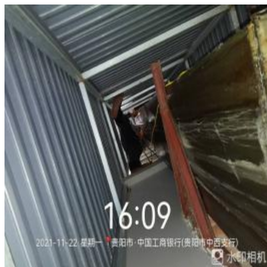
外墙管道施工
