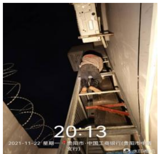
外墙管道施工中
