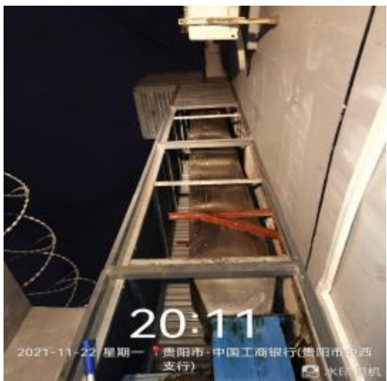
外墙管道施工中
