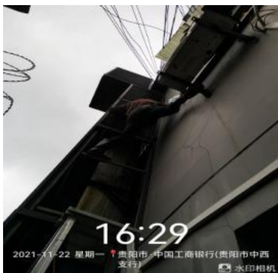
外墙管道施工中
