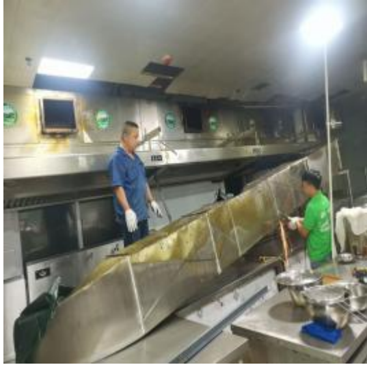
管道改装施工中
