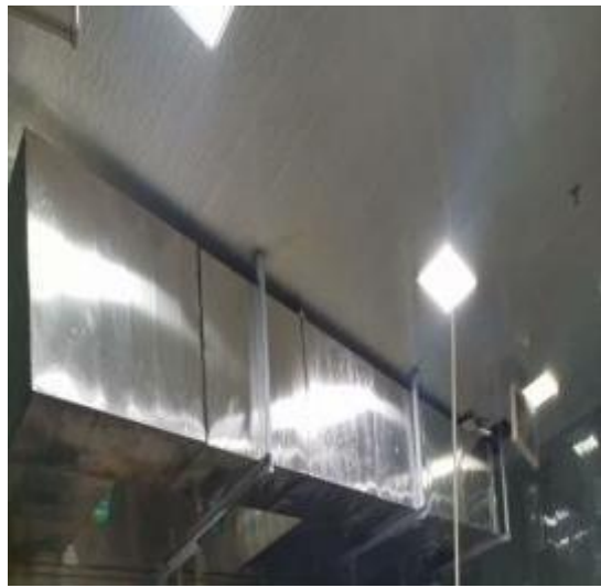
管道改装施工后
