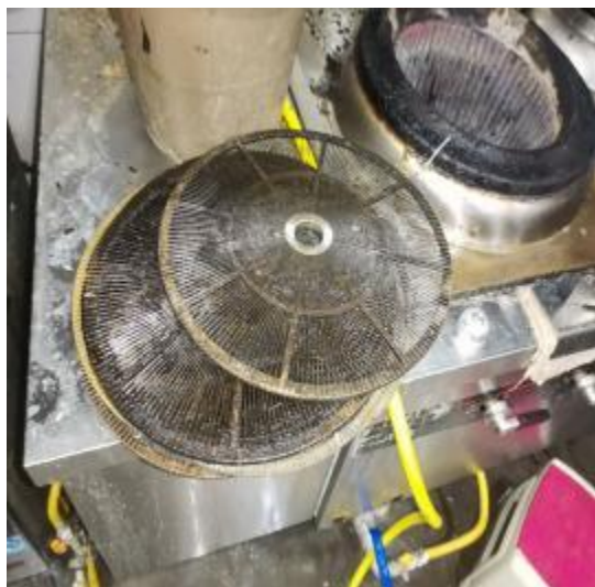
烟罩风扇过滤网清洗前
