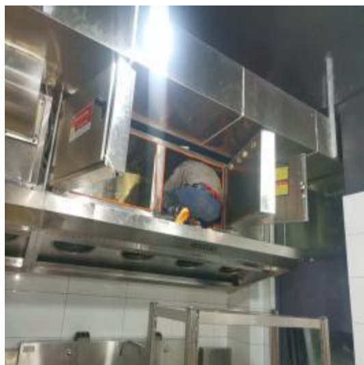
净化器机箱施工中
