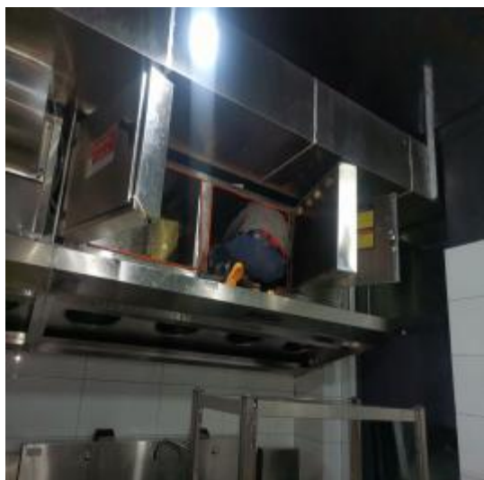
净化器机箱施工中
