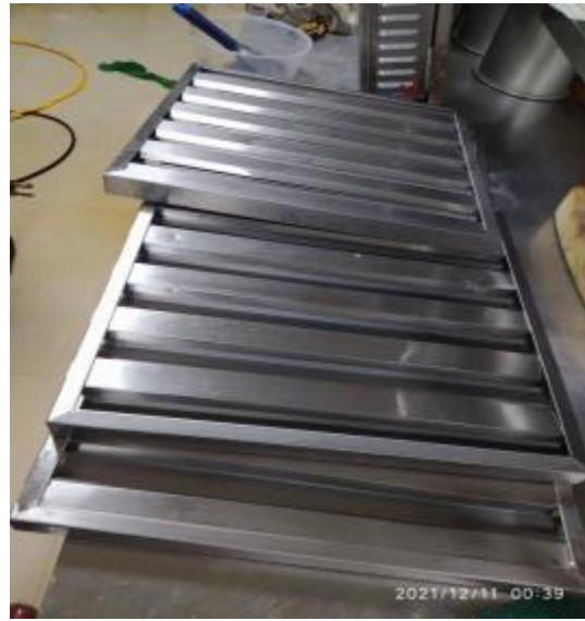
防火板清洗后
