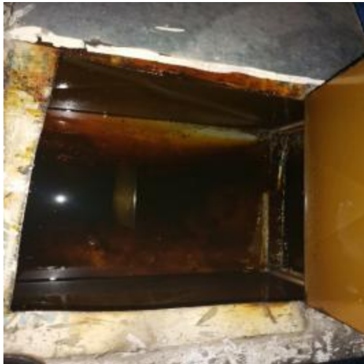
垂直管道施工
