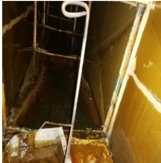
净化器内部施工
