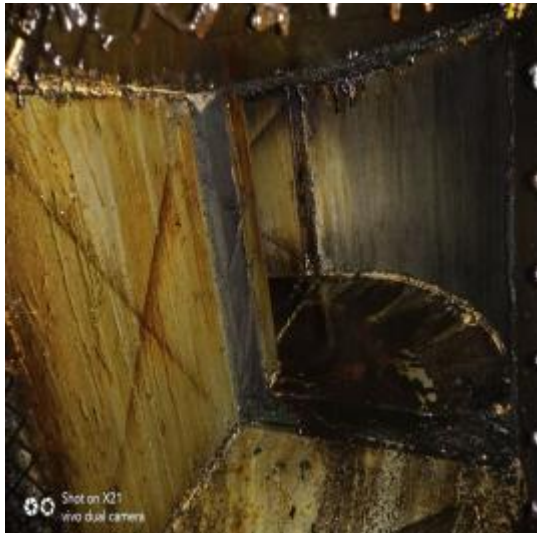
平台管道清洗前
