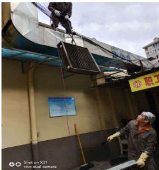
净化器施工中
