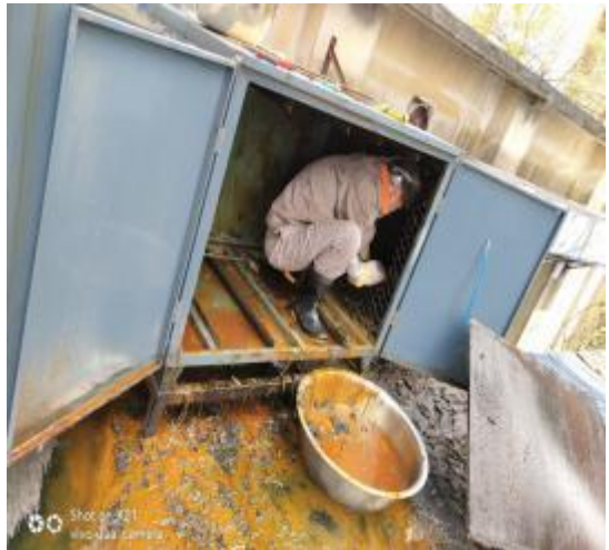
净化器内部施工
