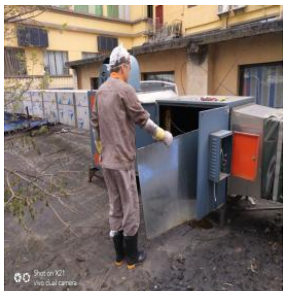
净化器施工中
