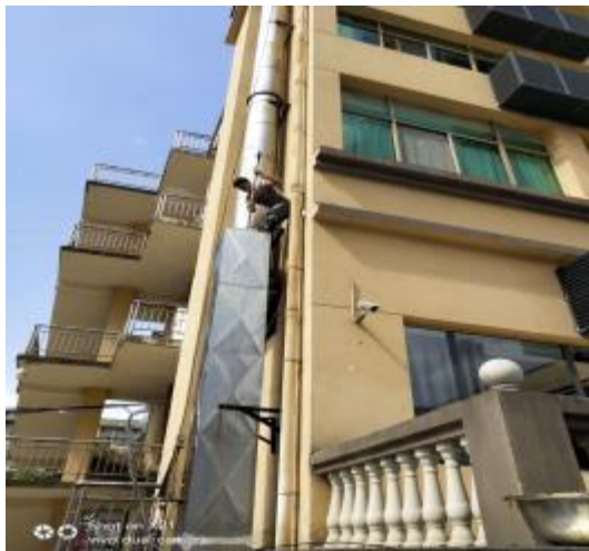
垂直管道施工
