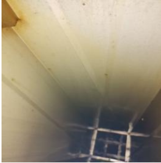
垂直管道清洗前 2
