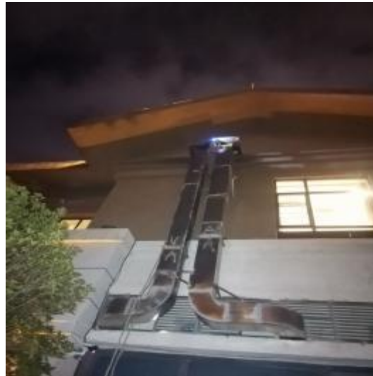
垂直管道施工中
