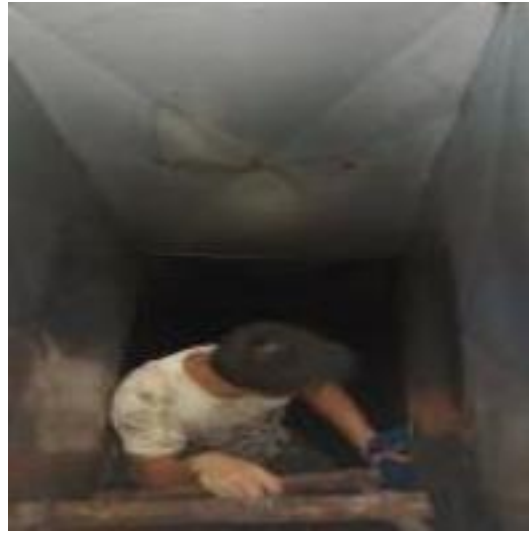
垂直管道施工中 2
