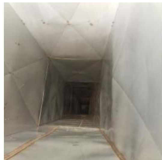
垂直管道清洗前 1
