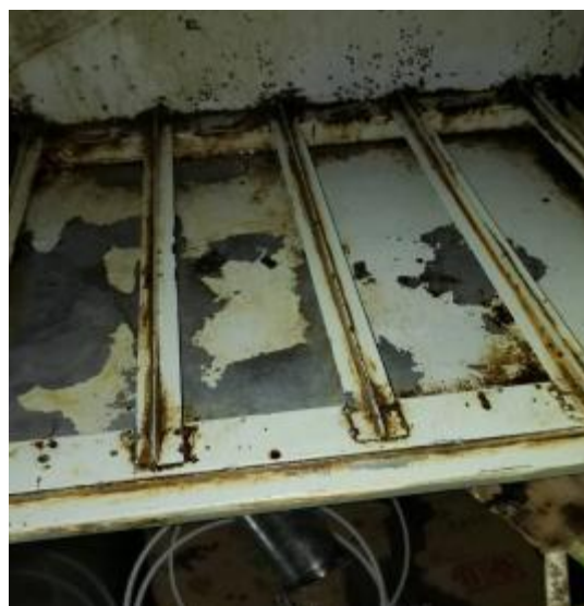
净化器内部清洗后
