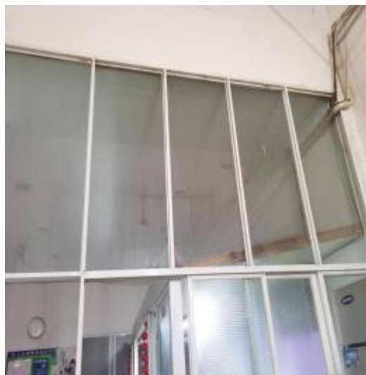
厨房玻璃清洗后
