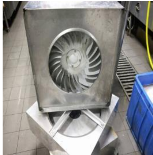
排风扇清洗后
