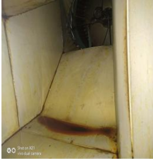
管道及风机清洗前
