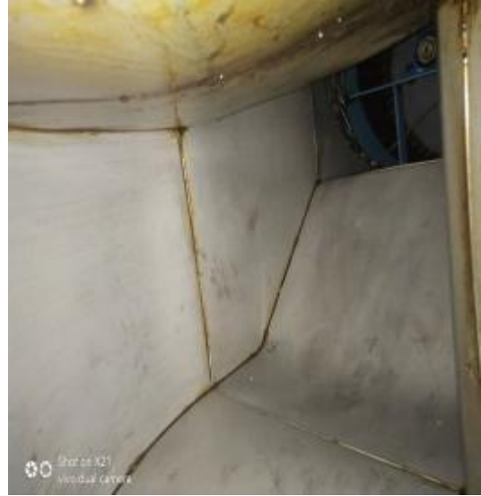
管道及风机清洗后
