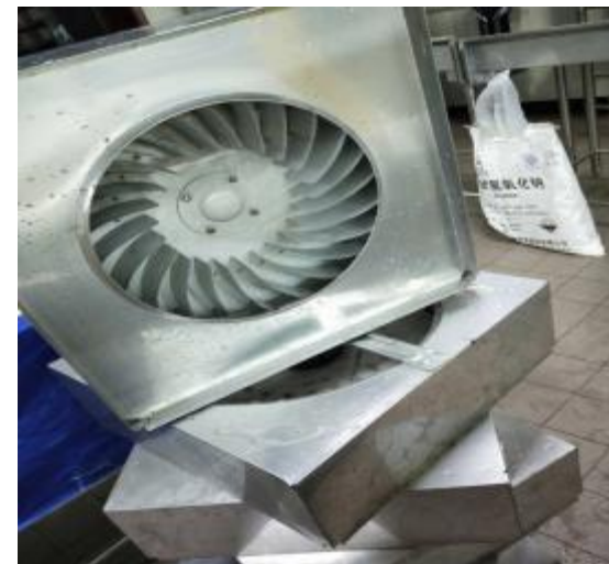
排风扇清洗后
