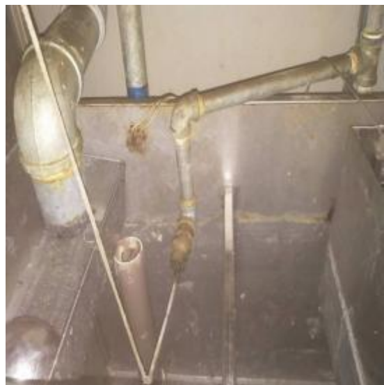
运水烟罩控制箱清洗后 2
