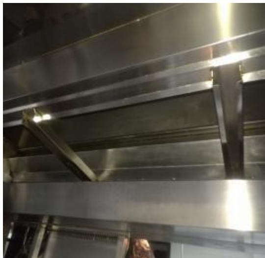
西厨房烟罩清洗后 2
