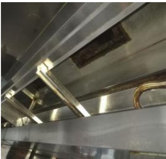
西厨房烟罩清洗后 1
