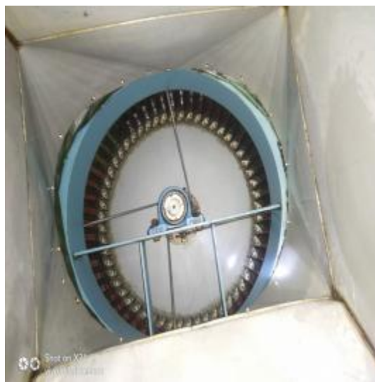
中厨房风机清洗后 2
