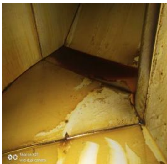
中厨房管道清洗前
