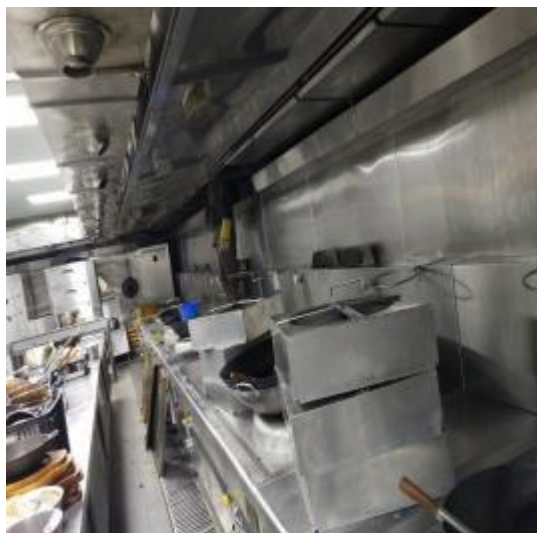
中厨房风扇清洗后
