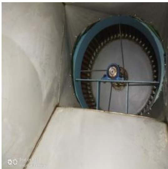
中厨房风机清洗后 1
