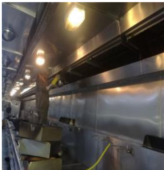
中厨房烟罩施工 1
