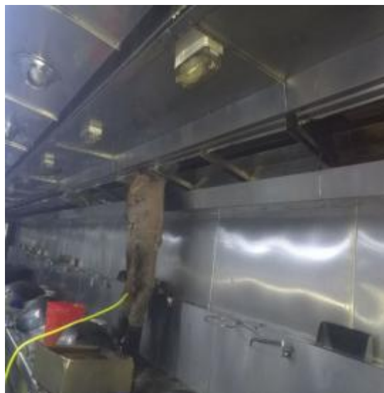
中厨房烟罩施工 2
