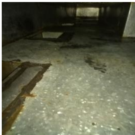
川菜厨房管道清洗后
