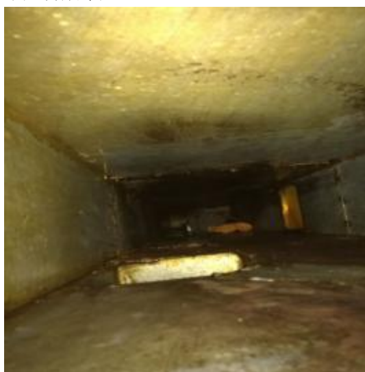
中厨房管道清洗前 1
