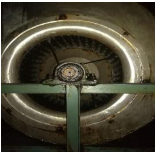
西厨房风机清洗后
