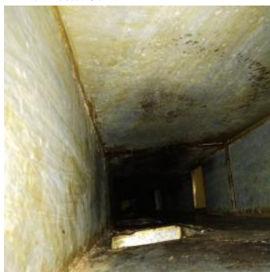
中厨房管道清洗后 1
