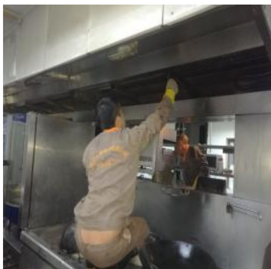
西厨房烟罩施工 1
